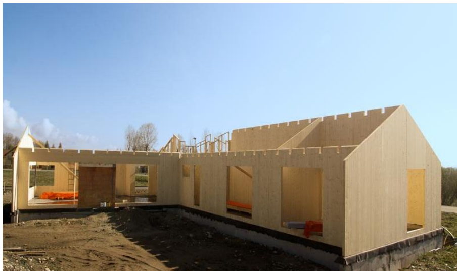
Obrázek 8: Ukázka stavby z masivních CLT panelů (zdroj: http://www.kontraktng.sk/sk/Sluzby/CLT-panely.html )
