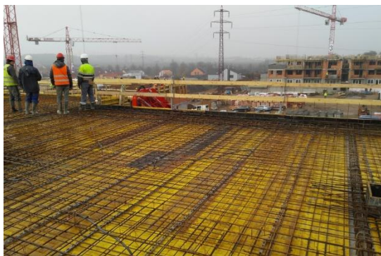
9. Betonáž stropní konstrukce
