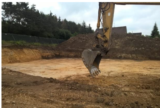
1. Hloubení stavební jámy
