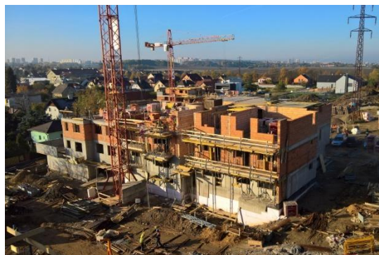
10. Zdění svislých konstrukcí ve 3.NP
