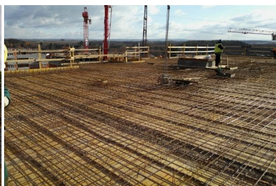
8. Přejímka stropní konstrukce
