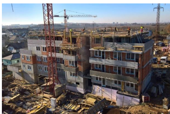
11. Armování střešní konstrukce
