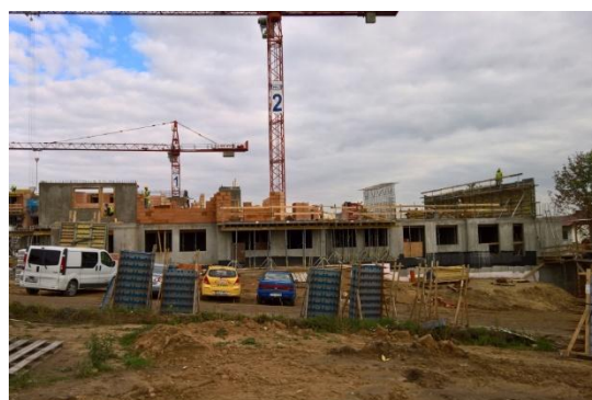
7. Svislé nosné konstrukce ve 2.NP
