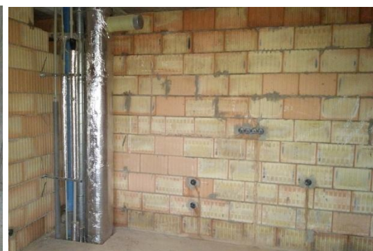
16. Namontované stoupací potrubí
