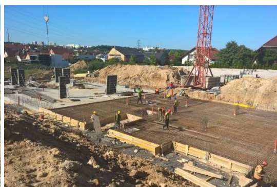
4. Armování, betonáž základové desky
