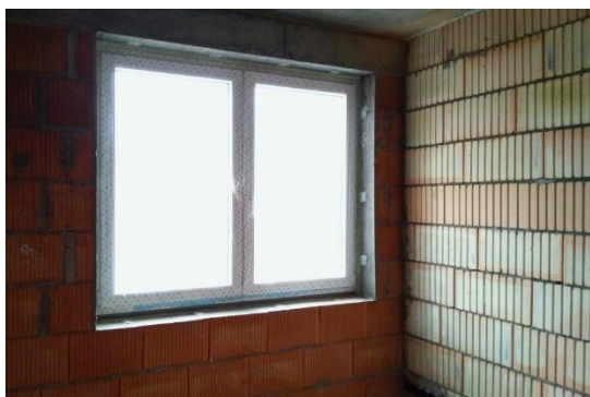
13. Osazená okenní výplň otvoru
