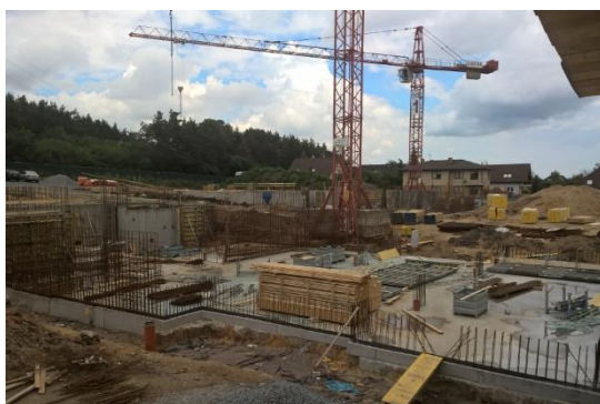
5. Armování, bednění svislých stěn 1.PP
