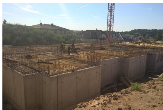
6. Armování stropu nad 1.PP
