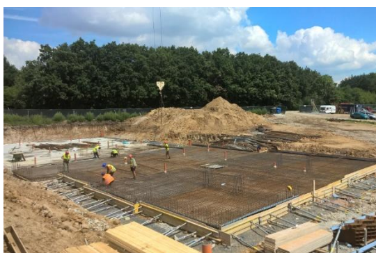
3. Armování, betonáž základové desky
