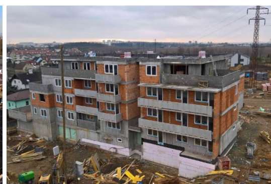
12. Hotová hrubá stavba
