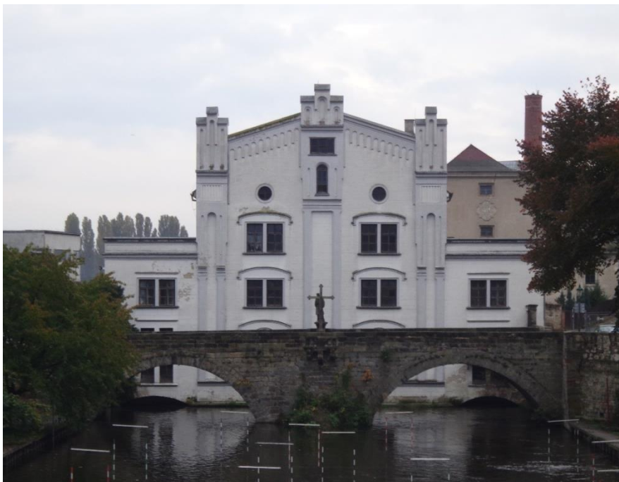
Obr. č. 13 _ Severozápadní pohled (vlastní zdroj)
