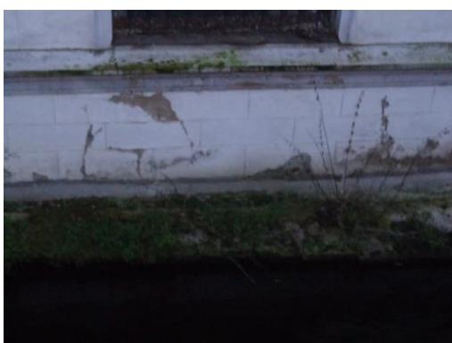
Obr. č. 53 -56 _ Severozápadní fasáda - oblast s viditelnou zvýšenou vlhkostí (vlastní zdroj)
