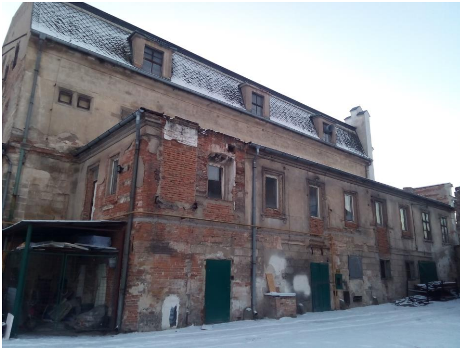
Obr. č. 19 _ Jihozápadní pohled (vlastní zdroj)
