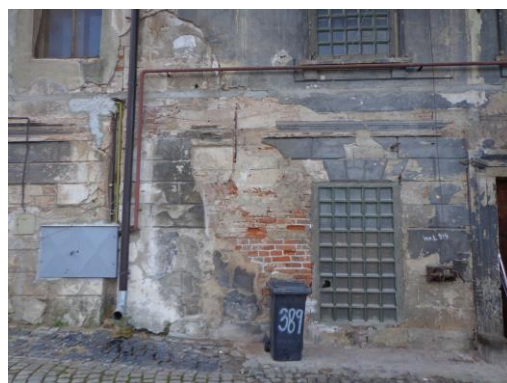
Obr. č. 53 -56 _ Severozápadní fasáda - oblast s viditelnou zvýšenou vlhkostí (vlastní zdroj)
