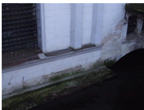
Obr. č. 53 -56 _ Severozápadní fasáda - oblast s viditelnou zvýšenou vlhkostí (vlastní zdroj)
