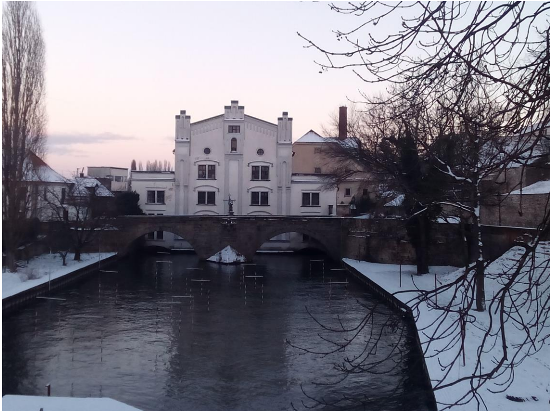
Obr. č. 1 _ Schubertův mlýn - pohled severozápadní (vlastní zdroj)
