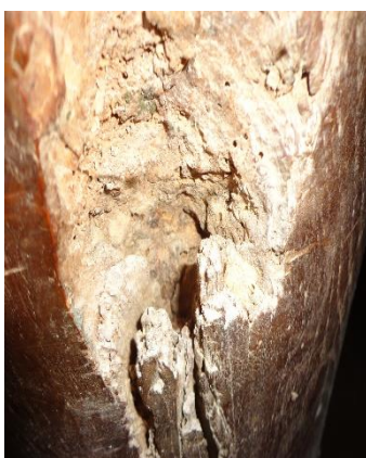
Obr. č. 24 - 29 _ Porušená dřevěná konstrukce. (vlastní zdroj)
