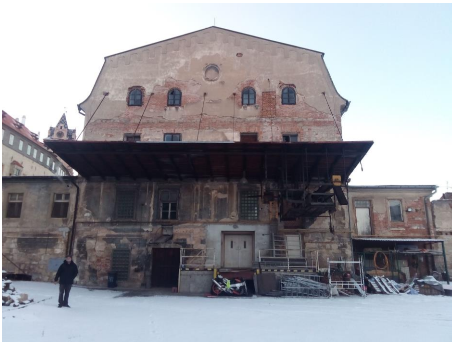
Obr. č. 15 _ Jihovýchodní pohled (vlastní zdroj)
