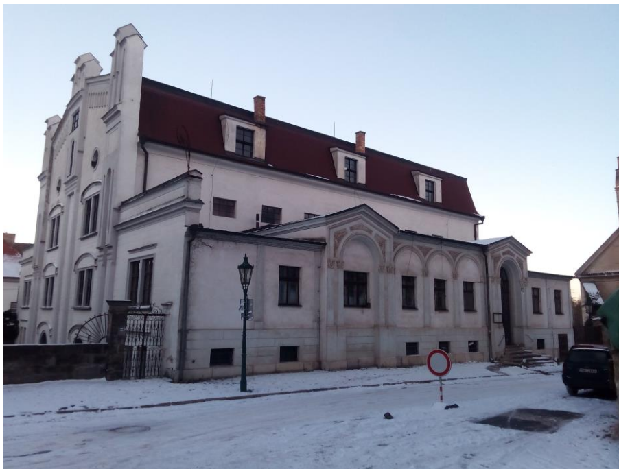
Obr. č. 17 _ Severovýchodní pohled (vlastní zdroj)
