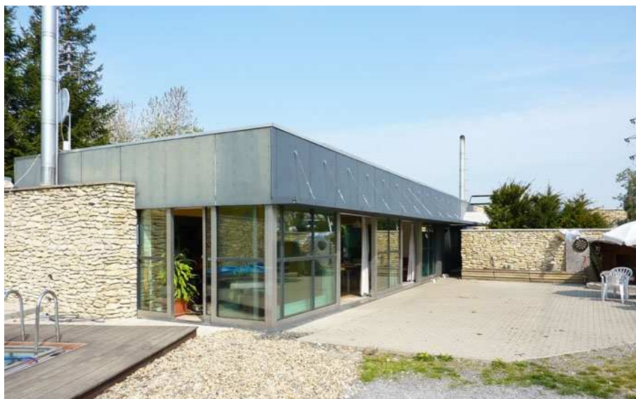
Obrázek 2: Pohled na prosklenou stěnu, převzato z: [5]
