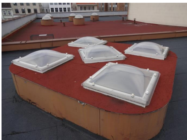
Obr. 2.19 a 2.20 Střešní světlíky (sdružené, bodové)
