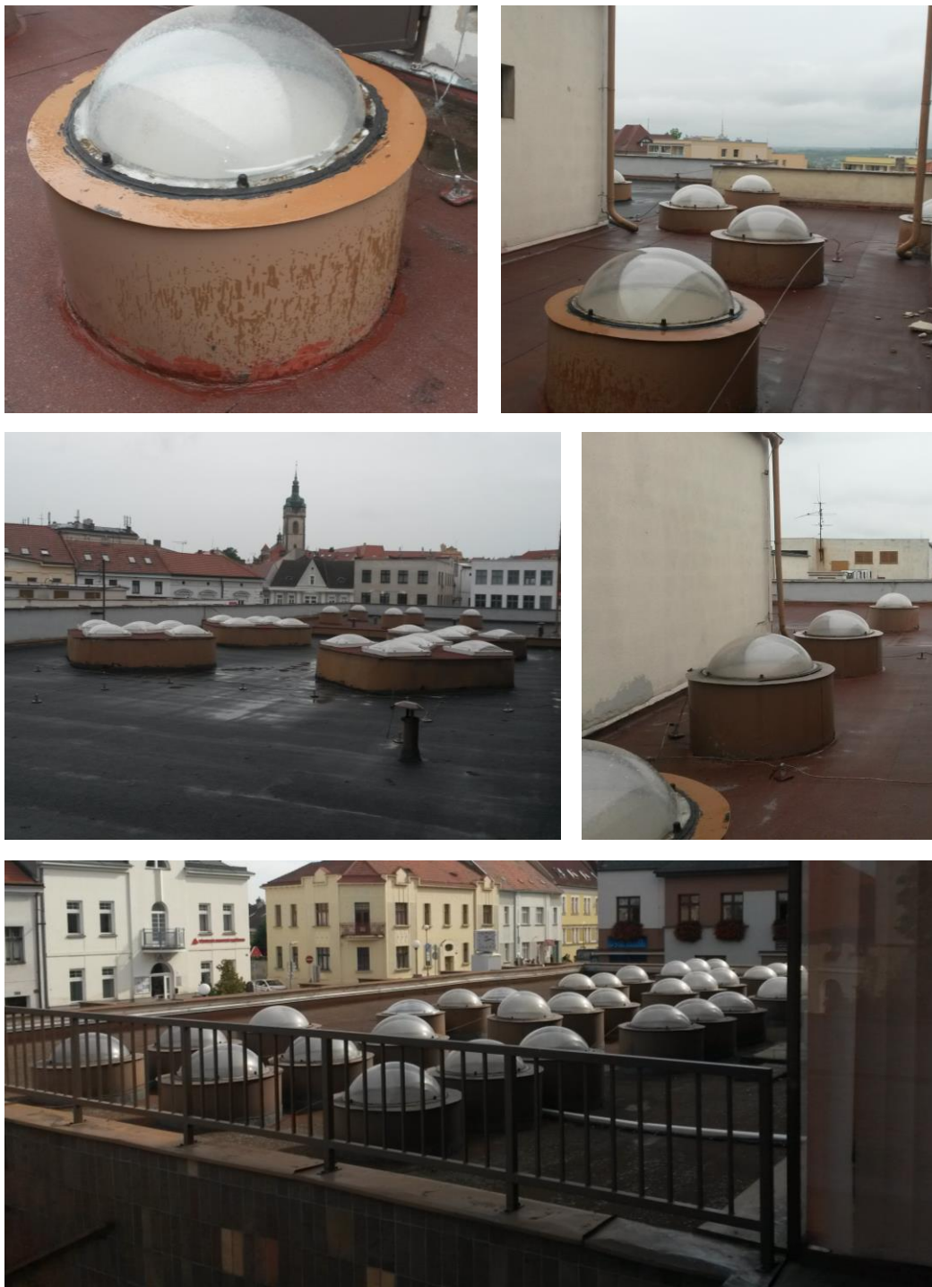
Obr. 3.7 Fotografie světlíků pořízené při prohlídce střechy objektu (listopad 2016)
