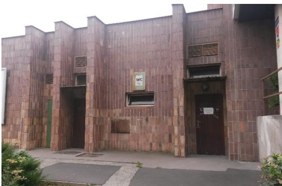
Obr. 2.11 Trafostanice a veřejné WC (zavřeno)
