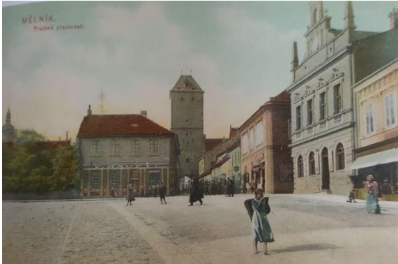
Obr. 4 Pohled k vodárenské věži (rok 1899) [35]
