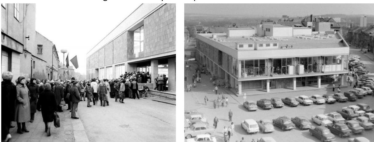
Fotografie 3 a 4 - Výstavba prvního obchodního domu
