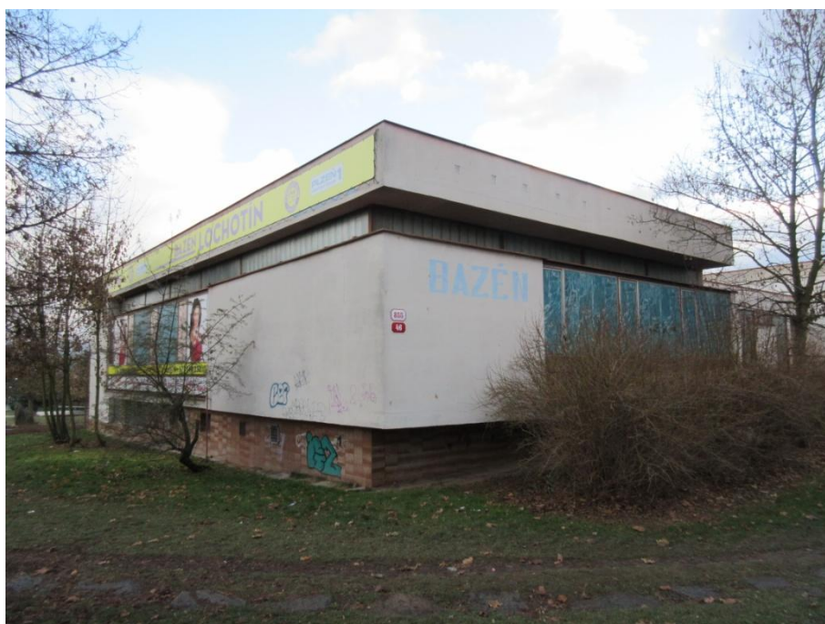
Obr. 3.2.11 Pohled na část A - zázemí, kanceláře
