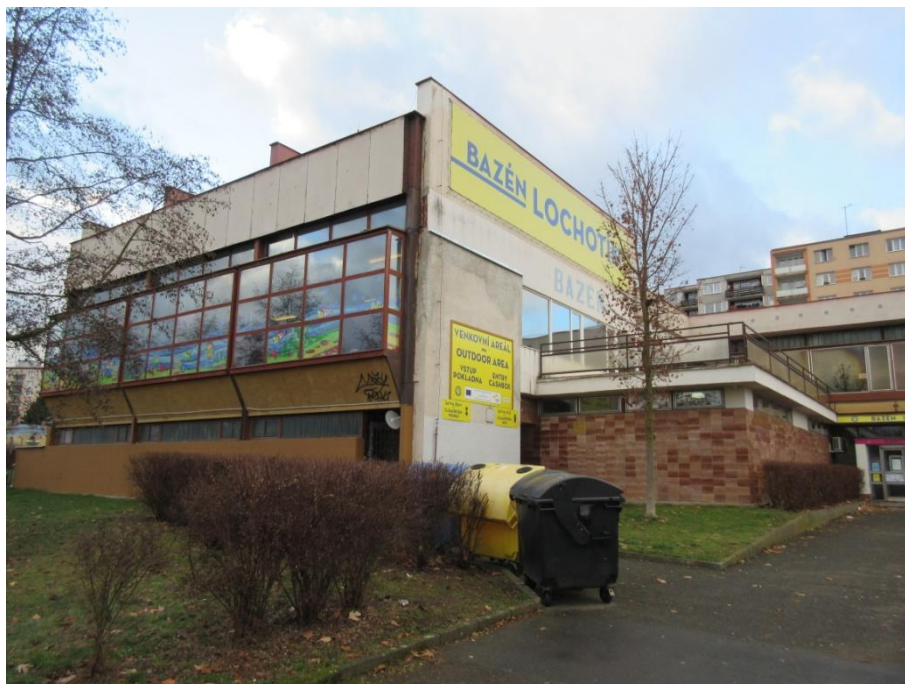
Obr. 3.2.8 Pohled na část B - bazénová hala dětského bazénu (východní orientace)
