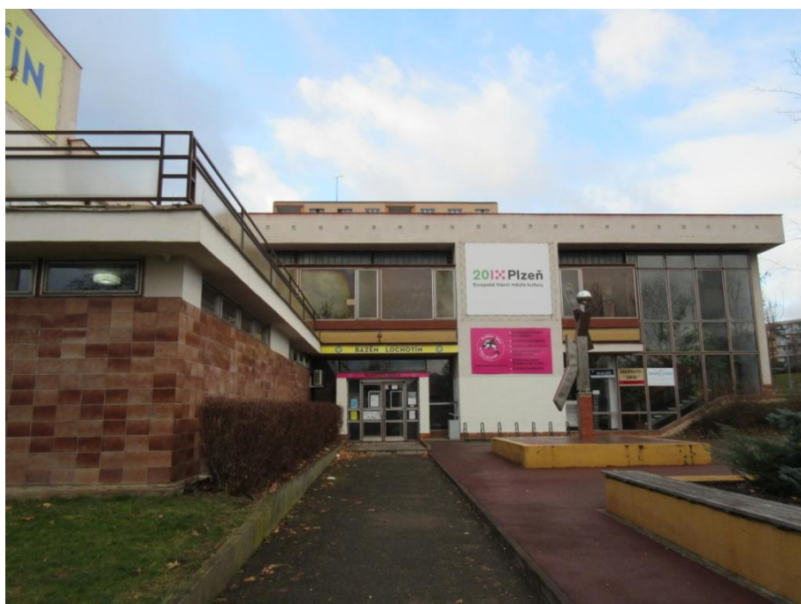
Obr. 3.2.7 Pohled na hlavní vstup
