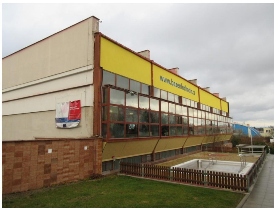
Obr. 3.2.10 Pohled na část B - bazénová hala velkého bazénu (jižní orientace)
