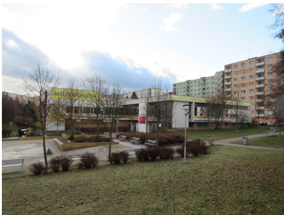
Obr. 3.2.6 Celkový pohled na objekt plaveckého bazénu
