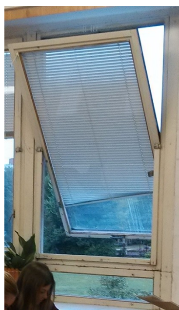
Obr. č. 15: Foto okna v učebně B18
