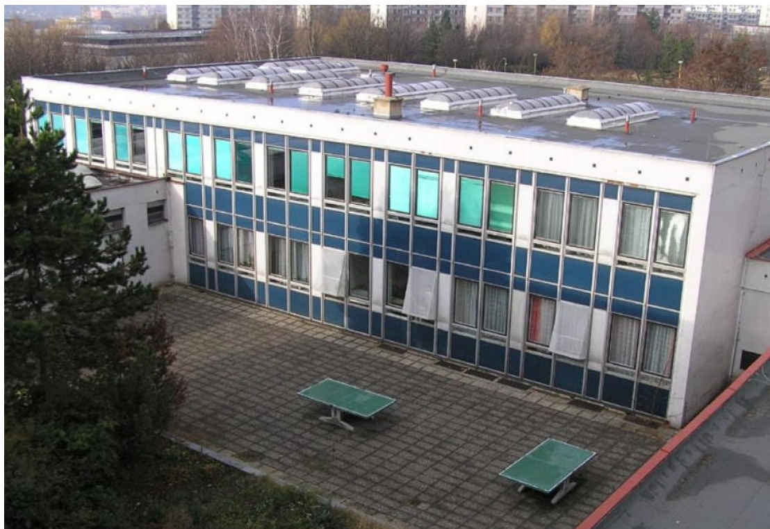
Obr. č. 8: Pohled na pavilon B
