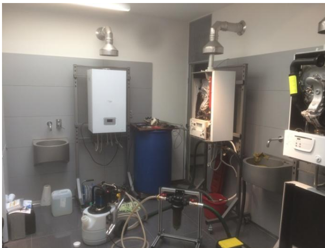
Obr. 1.19 Připojení čisticího zařízení na soustavu (autor)
