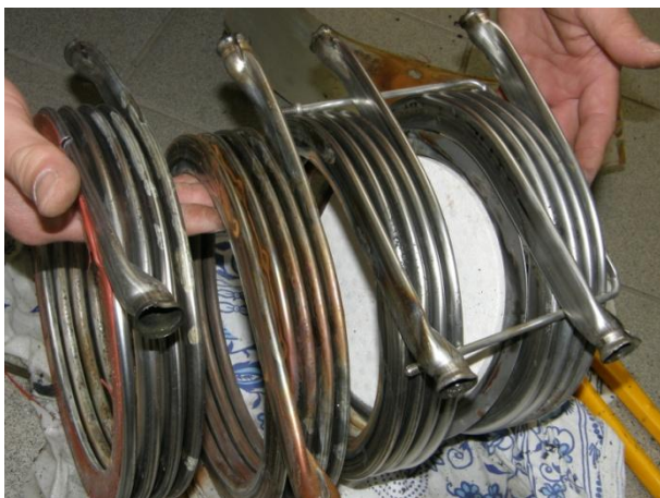
Obr. 1.22 Smyčky výměníku (Václav Eberl, Vaillant Group Czech)
