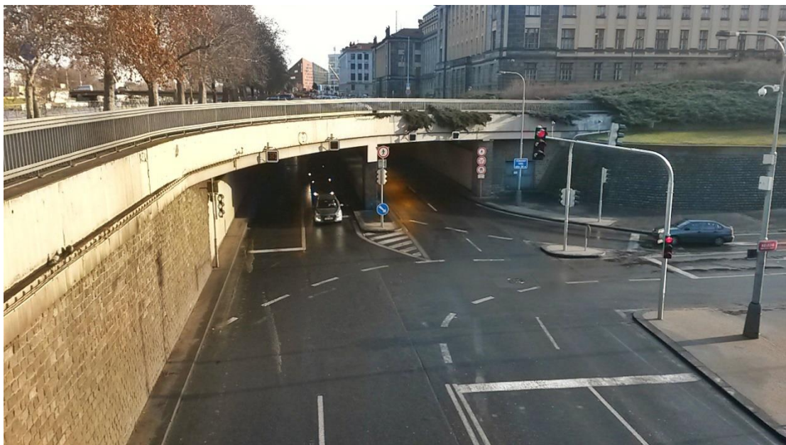
Obrázek 10 Západní portál Těšnovského automobilového tunelu (leden 2017)
