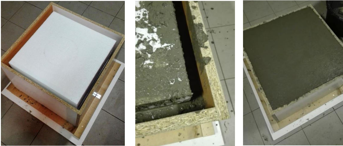
Obr. 8.2 Polystyrenové jádro, betonáž pontonu
