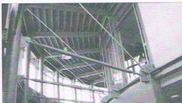
Abstützung zwischen äußeren Stahlstützen und innen liegenden Stahlträger
