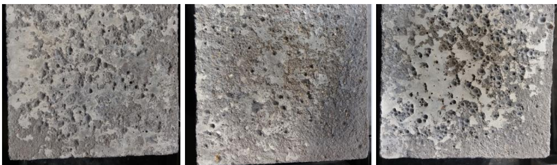
Obr. 43 – Porušený povrch krychlí vystavený zkoušení
