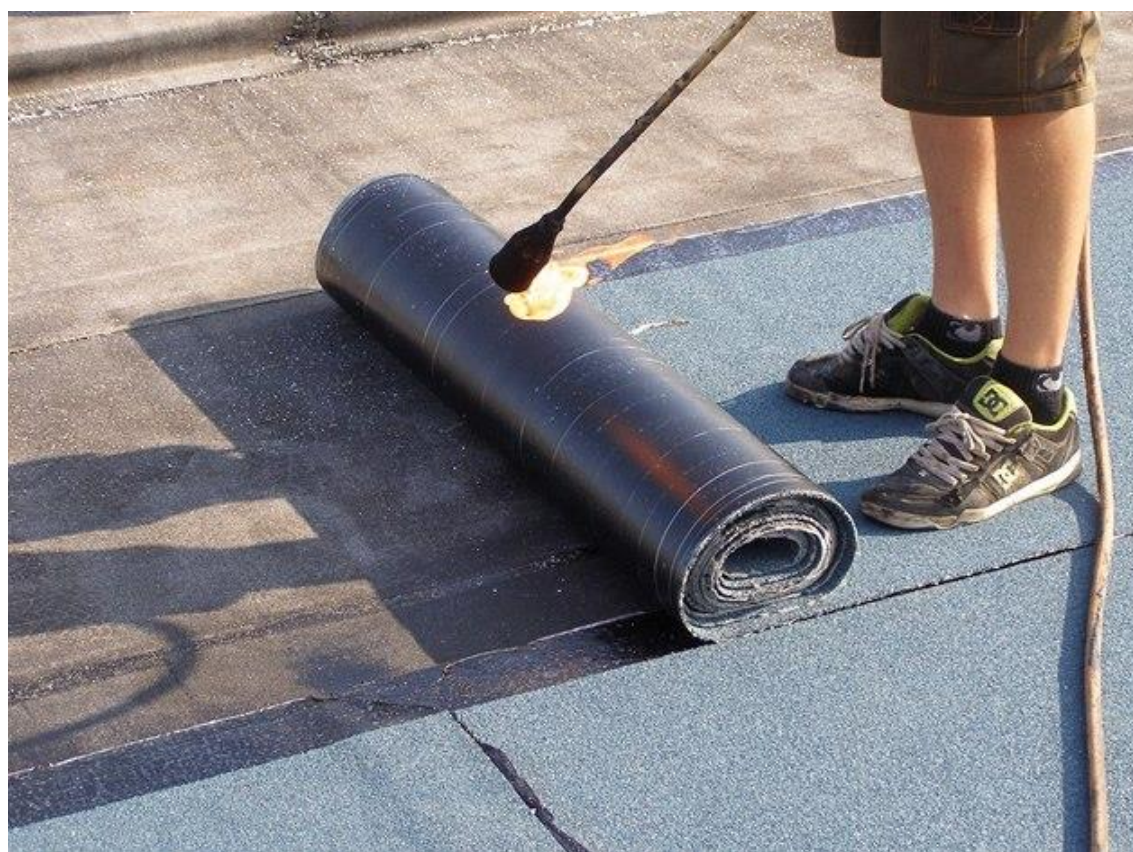
Obrázek 1 – Pokládka asfaltových pásů [11]
