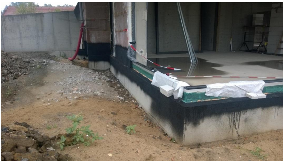
Obrázek 3 – Štěrková hydroizolace spodní stavby
