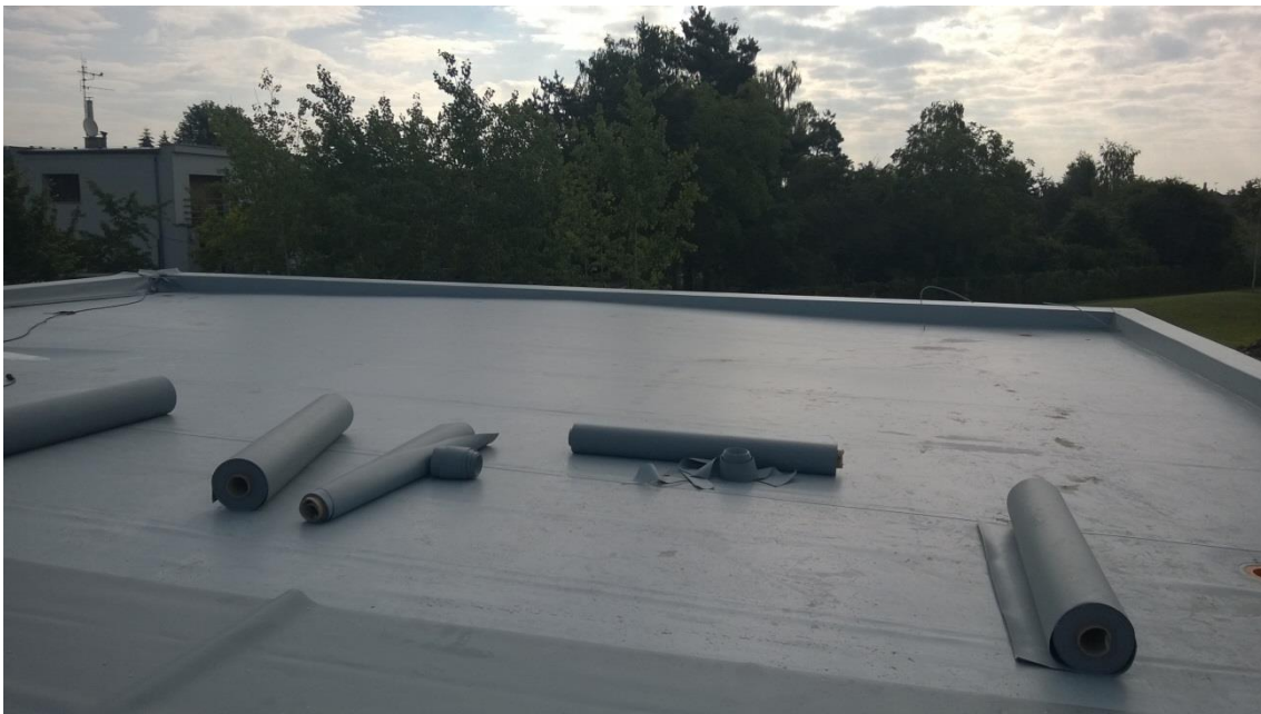
Obrázek 2 – Hydroizolace z plastové folie
