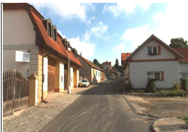
Obrázek 23 Pohled pod starou hasičskou zbrojnicí s komplikovaným výškovým rozdílem ve směru k silnici I/16 Zdroj: Autor
