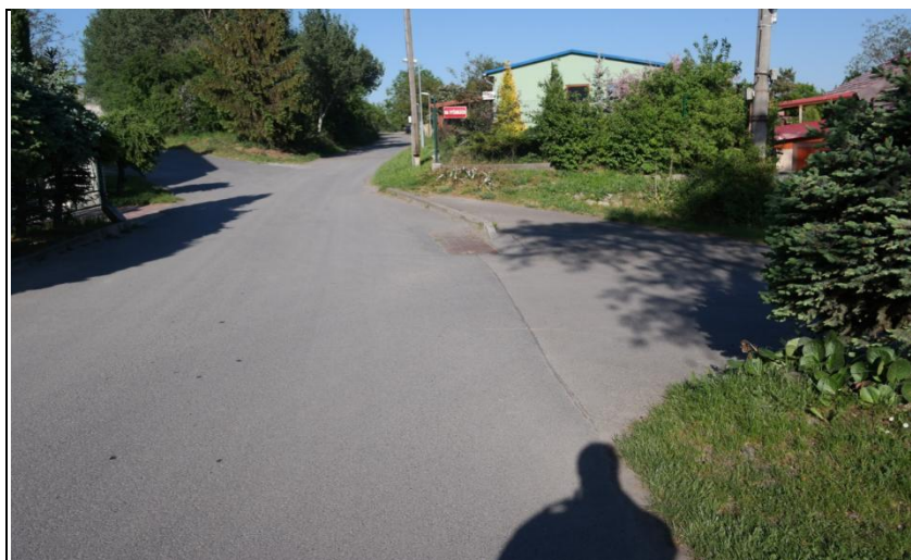
Obrázek 19 Kanalizační vpust' vytvářející pevnou překážku
