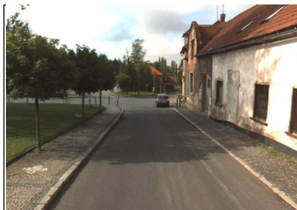
Obrázek 24 Pohled na aktuální stav chodníků ve směru k Tyršovu náměstí Zdroj: Autor
