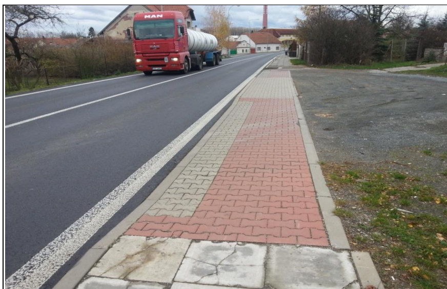
Obrázek 14 Špatné optické znázornění chodníkového vjezdu
