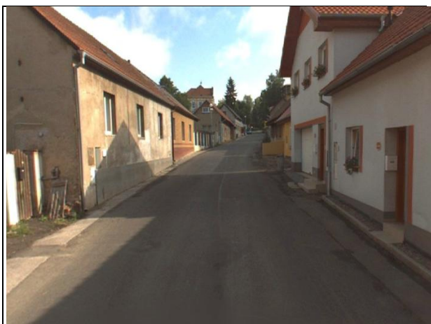
Obrázek 25 Absence chodníku, nebezpečný vstup z objektů přímo do vozovky
