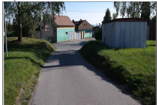
Obrázek 42 Pohled na křižovatku ze severovýchodního ramene ulice Hřbitovní
