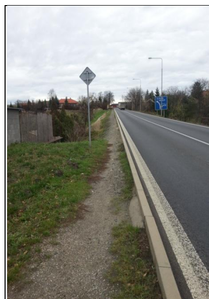
Obrázek 6 Silnice I/16 v místě začátku nově navrhovaného přechodu pro chodce
