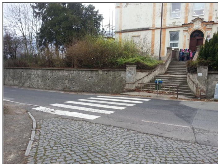
Obrázek 17 Nesprávně provedený přechod pro chodce
