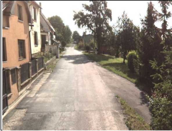
Obrázek 49 Pohled před křižovatkou západním směrem v ulici Hoření – příliš ostrý odbočovací úhel
