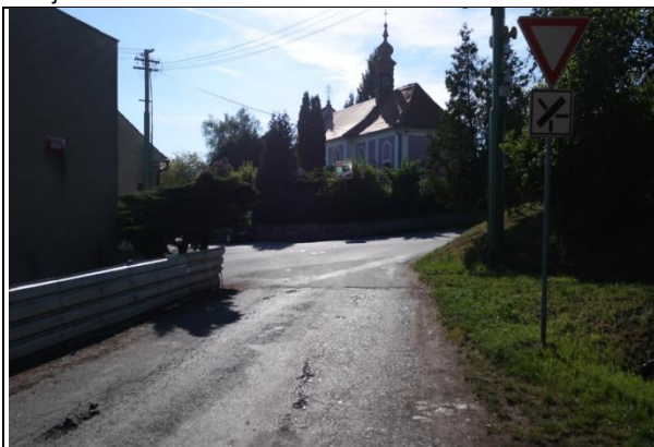
Obrázek 41 Pohled na křižovatku z jihovýchodního ramene ulice Hoření
