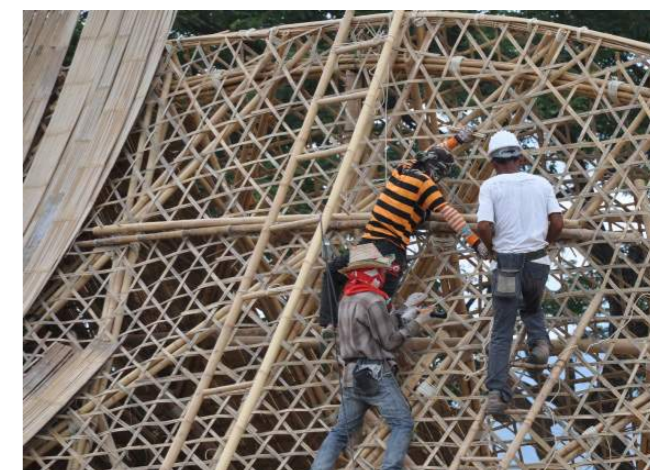
KONSTRUKCE STŘECHY Z BAMBUSU [13]
