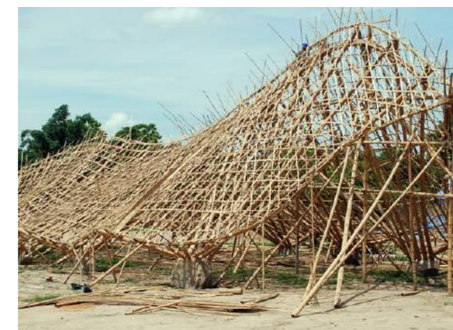
KONSTRUKCE STŘECHY Z BAMBUSU [13]
