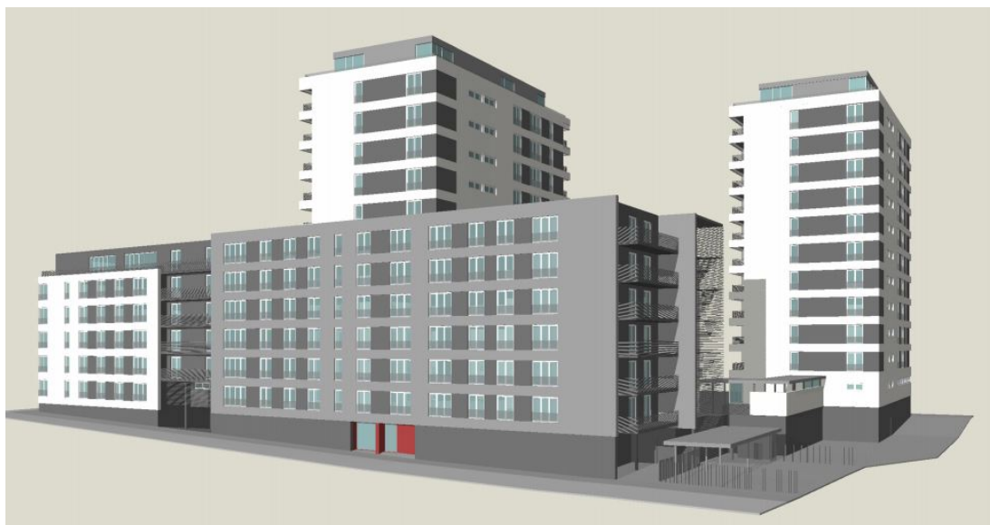
Obr. 20: Bytový komplex SILO SPOT – pohled z Nemocniční ulice (Převzato z [PD])
