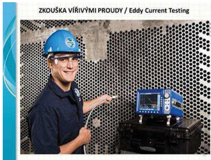
Obr. 12.5.1 Zkouška výměníku vířivými proudy
