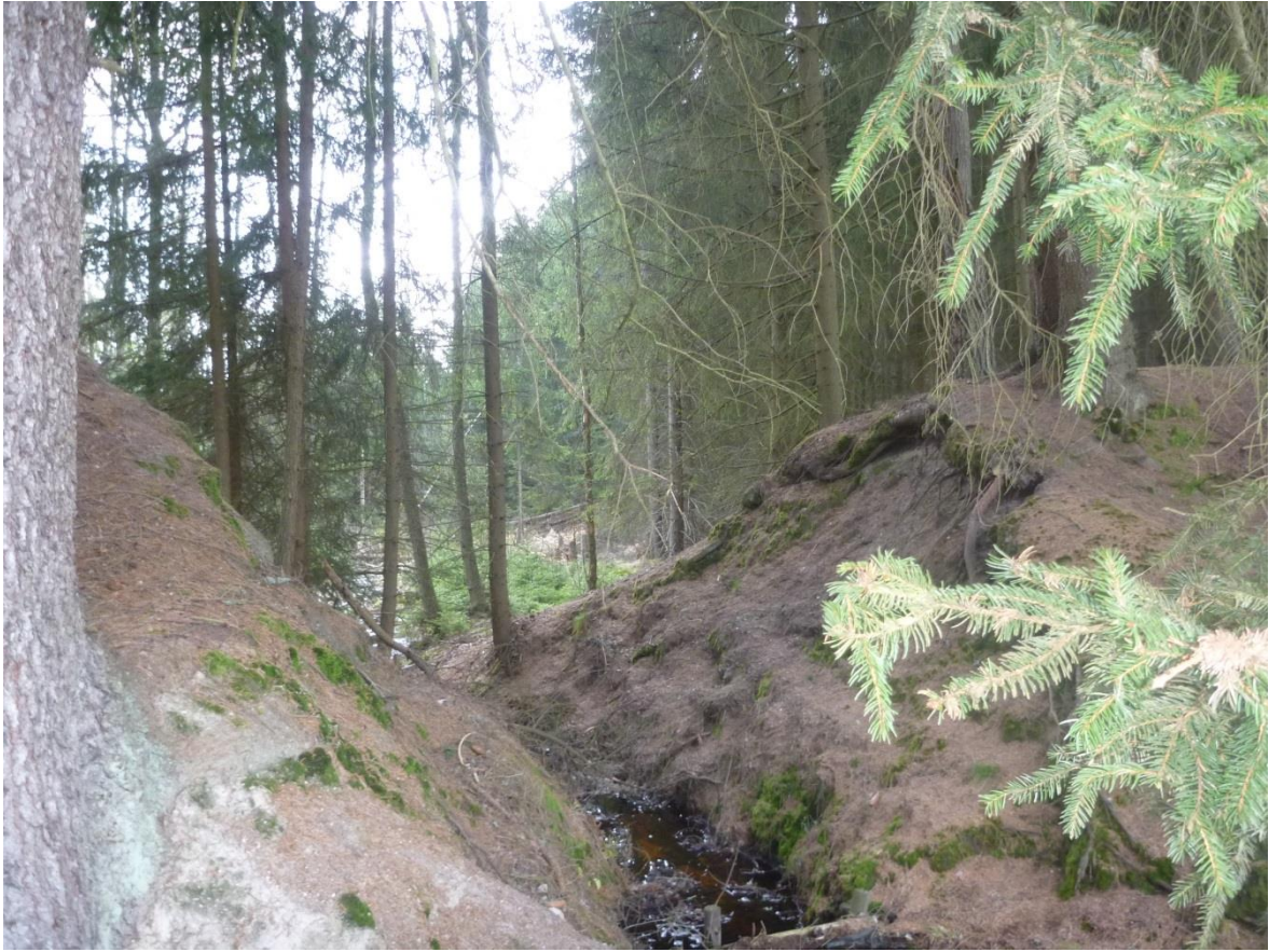
Obrázek 2-5 - Protržená hráz Malého rybníka, 17. 4. 2017
