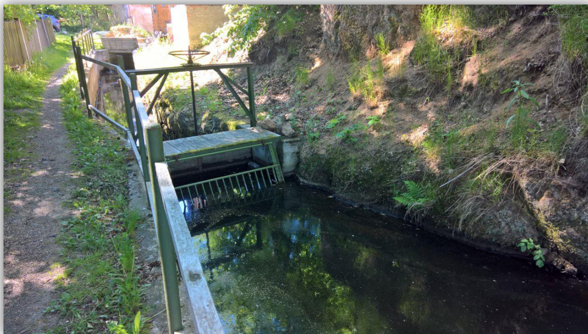
Obrázek 4-1 - Stavidlo a náhon na bývalý hamr 27. 5. 2017
