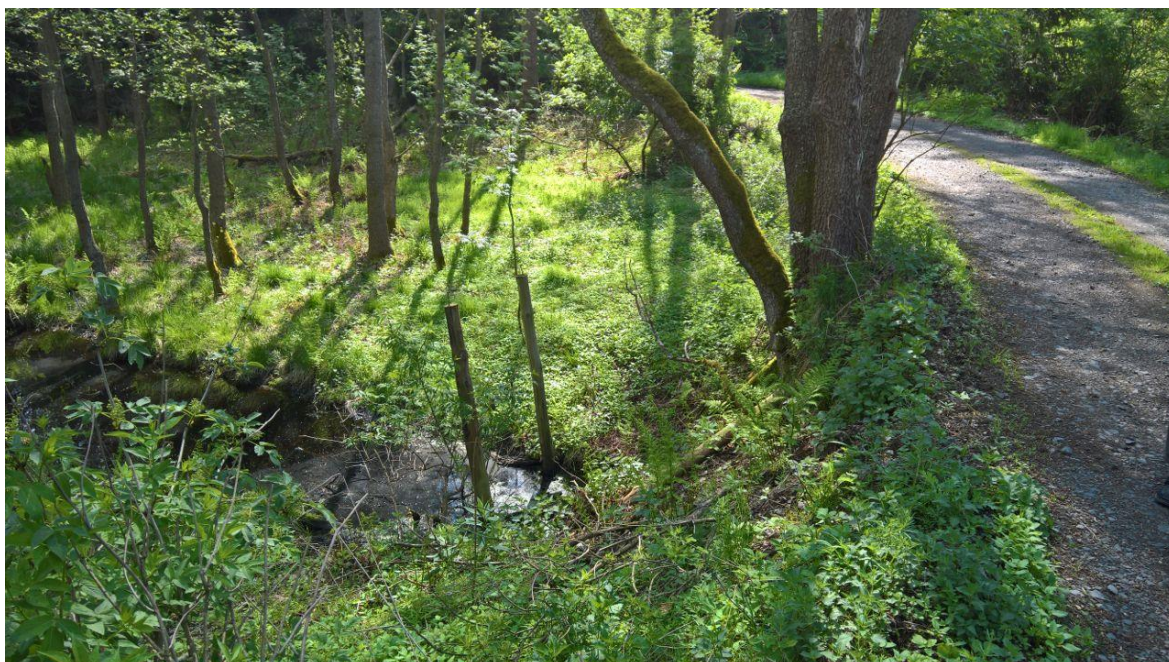
Obrázek 3-5 - Zbytek výpustného zařízení + výška hráze (Střední Žabka), 20. 5. 2017
