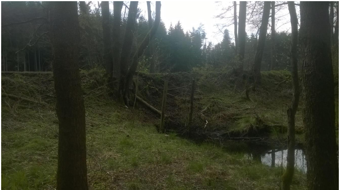
Obrázek 3- 3-4- Zbytek výpustného zařízení + výška hráze (Střední Žabka), 17. 4. 2017
