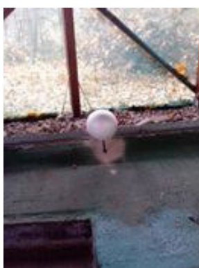
Obr. 5 Vřícovací bod, kulový terč
