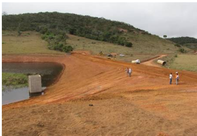
Obr. č.3 Uzávěr typu požerák umístěn při konstrukci nádrže (Brazílie); (11.4)
