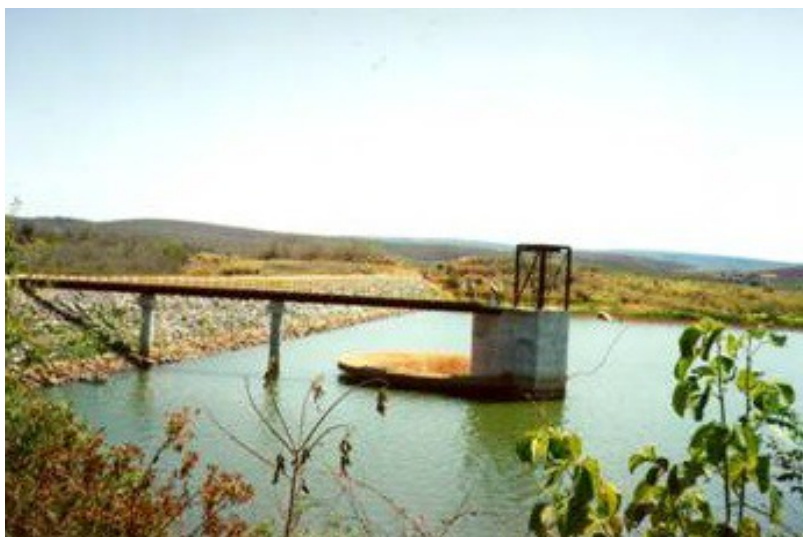
Obr. č.5 Příklad šachtového bezpečnostního přelivu; (11.4)
