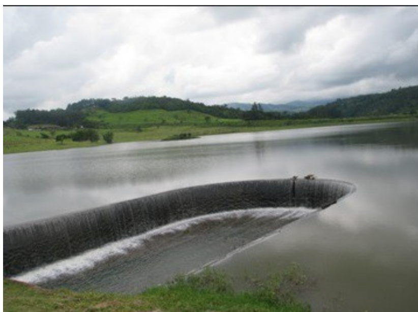
Obr. č.6 Kašnový bezpečnostní přeliv; (11.6)
