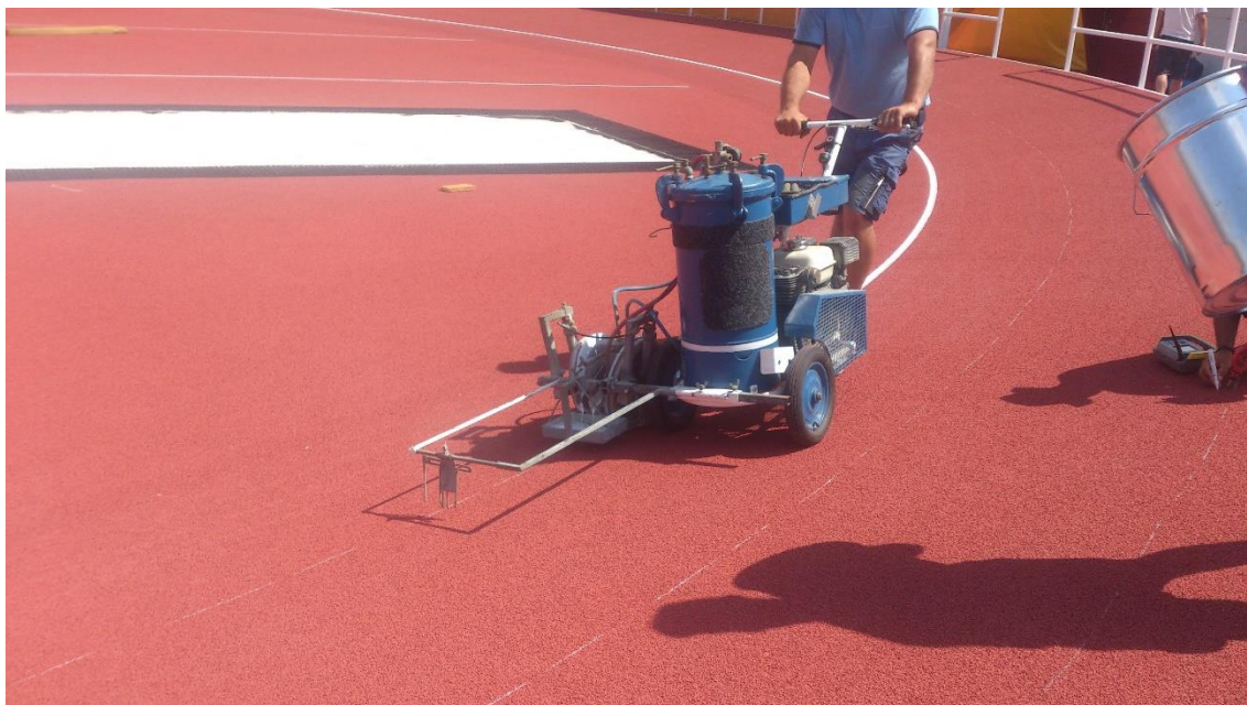
Obr. 44: Lajnování atletického oválu
