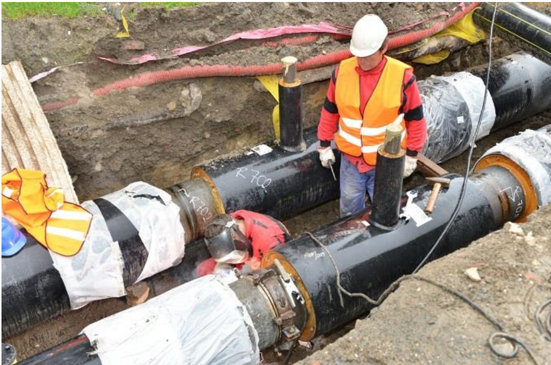
Obrázek 8: Rekonstrukce a přepojení horkovodů
