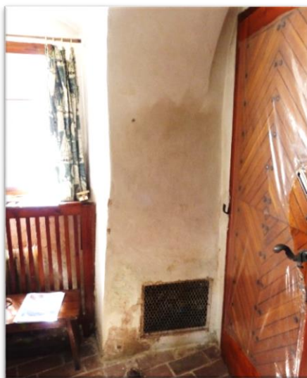
Obr. 35: Vzlínající vlhkost – interiér [Vytvořeno autorem]
