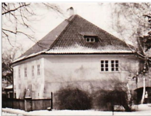
Obr. 25: Historický pohled na objekt [Zdroj: Stavebně historický průzkum-SÚRPMO, 06/1983]
