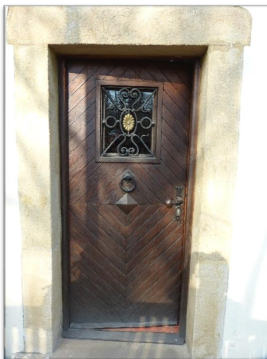
Obr. 14: Dveře v kamenném portálu - hlavní vstup [Vytvořeno autorem]
