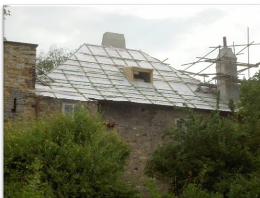
Obr. 10: Rekonstrukce střechy RD v r. 2005 [Foto: Patrik Kloss]
