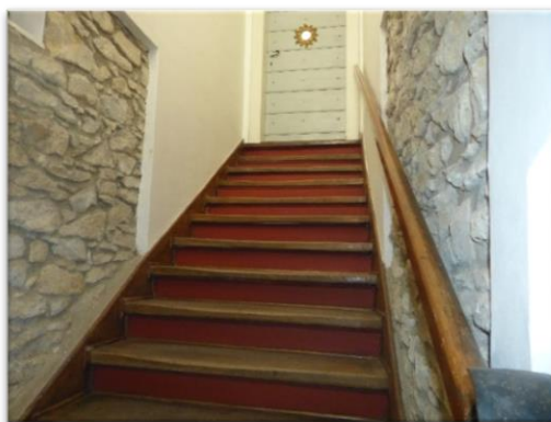
Obr. 9: Hlavní schodiště do 2.NP [Vytvořeno autorem]
