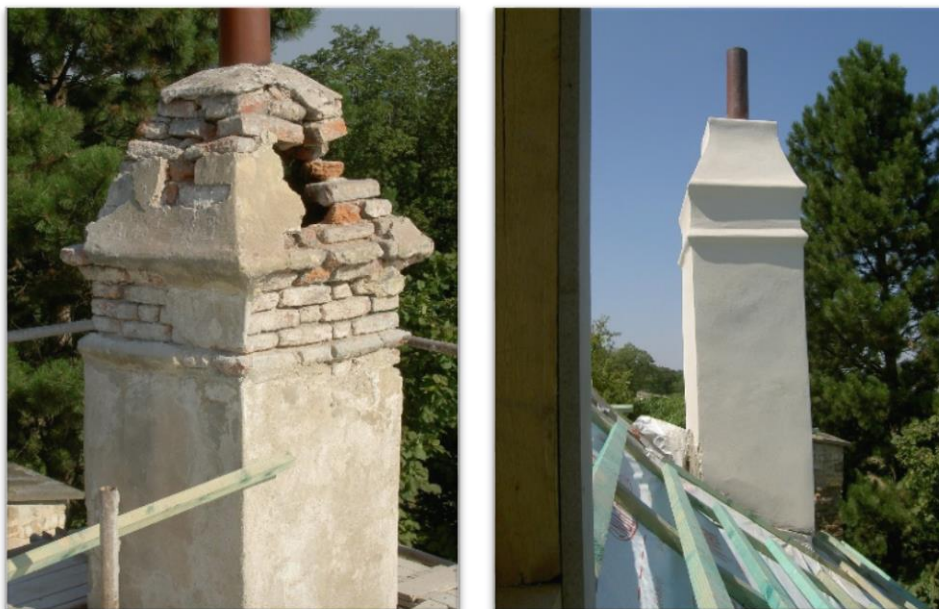
Obr. 12: Komín - rekonstrukce v r. 2005 před opravou (vlevo) [Foto: Patrik Kloss]
