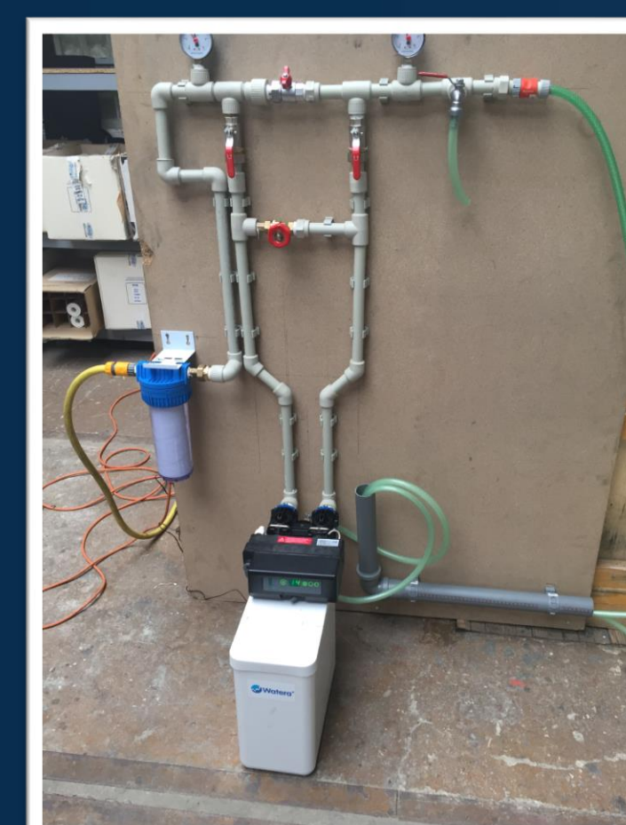
Změkčovač a zapojení změkčovače (zdroj: vlastní zpracování)
