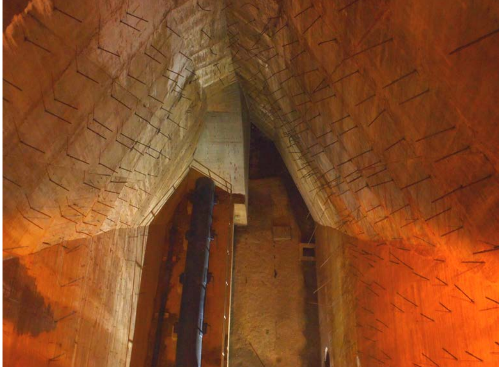
pohled na spodní výpust - bkok 17/18
