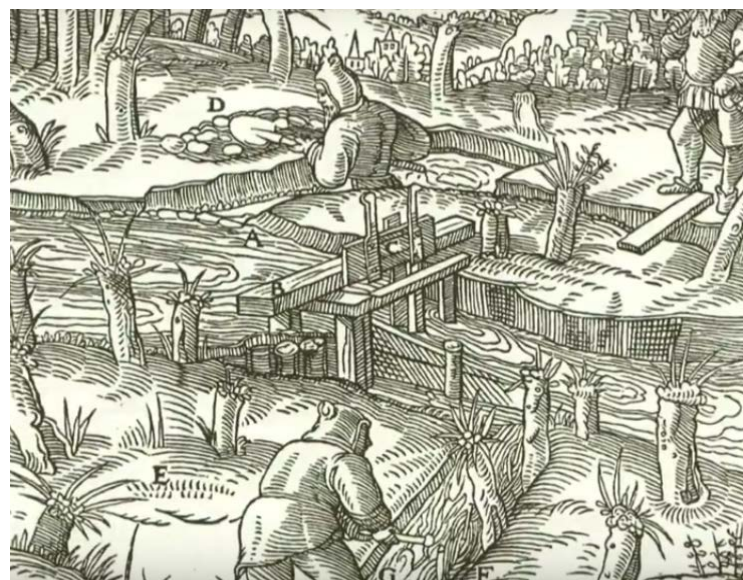
výstavba plavebního kanálu
