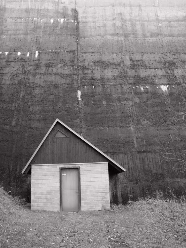
vstupní objekt - blok 10/11
