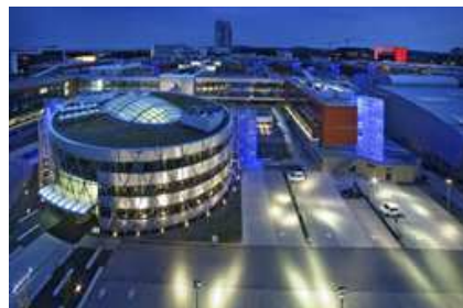
E_Nová budova CEITEC Výzkumný ústav
