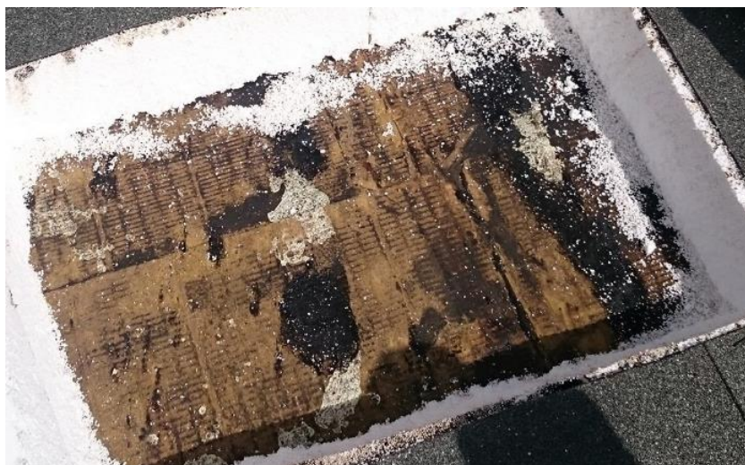
Obr. 43 - Původní parotěsná zábrana (foto autor)
