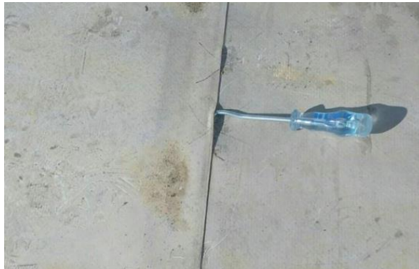
Obr. 37 - Chybné svaření spoje (foto firmy Folk s.r.o.)
