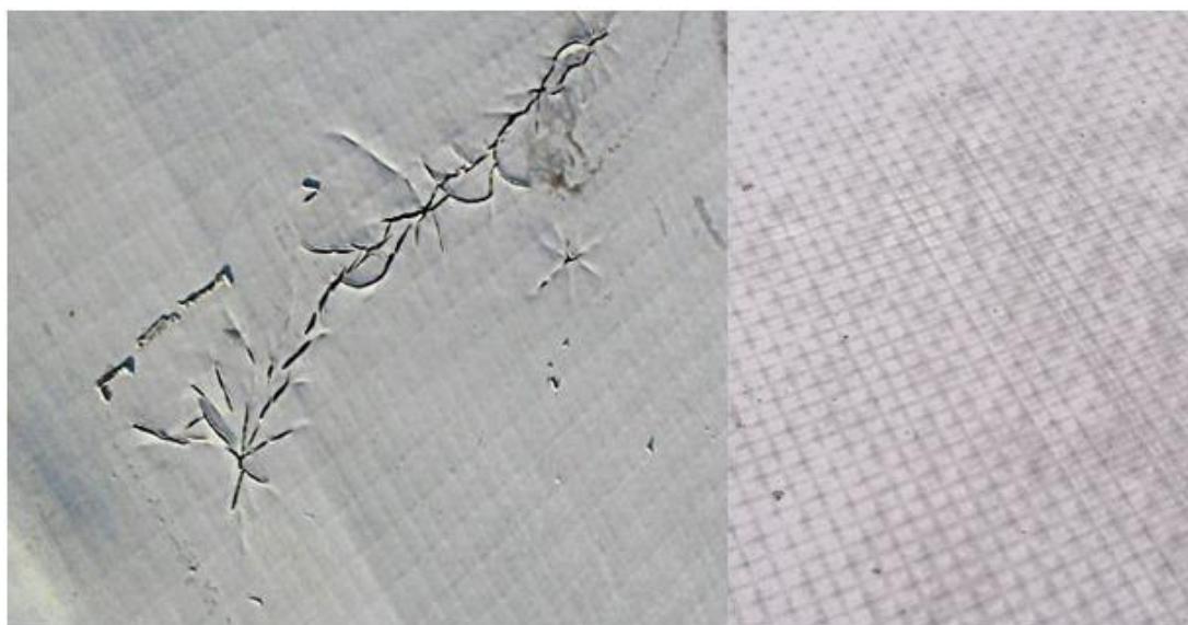
Obr. 34 - Praskání fólie v důsledku migrace změkčovadel a vykreslení vložky (převzato z [1])
