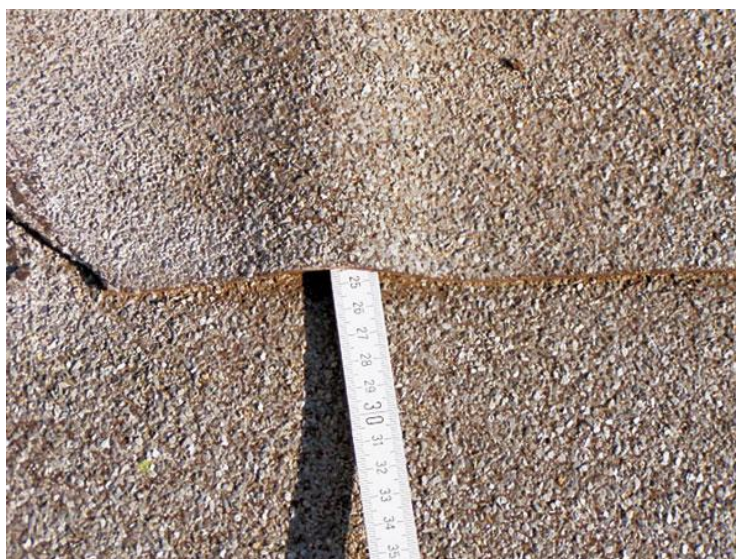
Obr. 26 - Objemové změny asfaltových pásů (převzato z [2])
