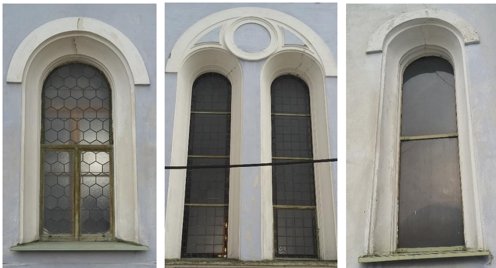
Obr. 24, 25, 26: Okenní otvory z exteriéru v 1. NP, zleva v presbytáři, příčné lodi a přístavku
