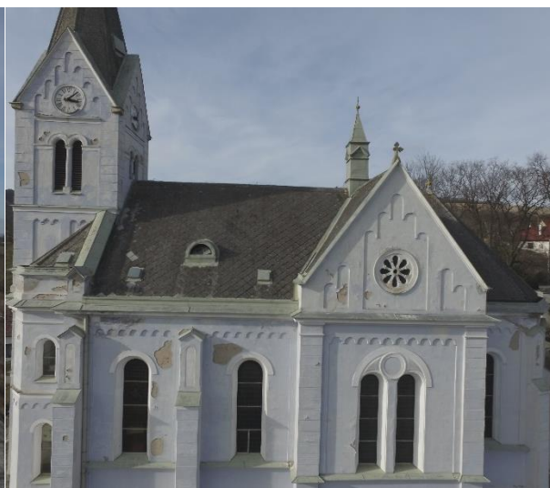
Obr. 30: Pohled na fasádní prvky z JV strany
