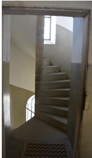
Obr. 17: Kamenné schodiště ke zvonům
