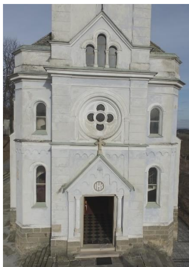
Obr. 29: Pohled na fasádní prvky z JZ strany
