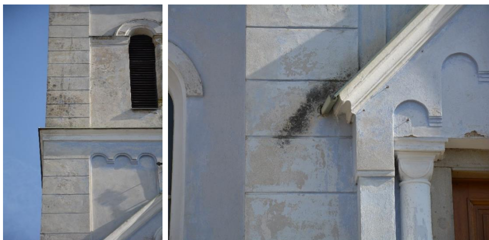
Obr. 49: Působení srážkové vody
