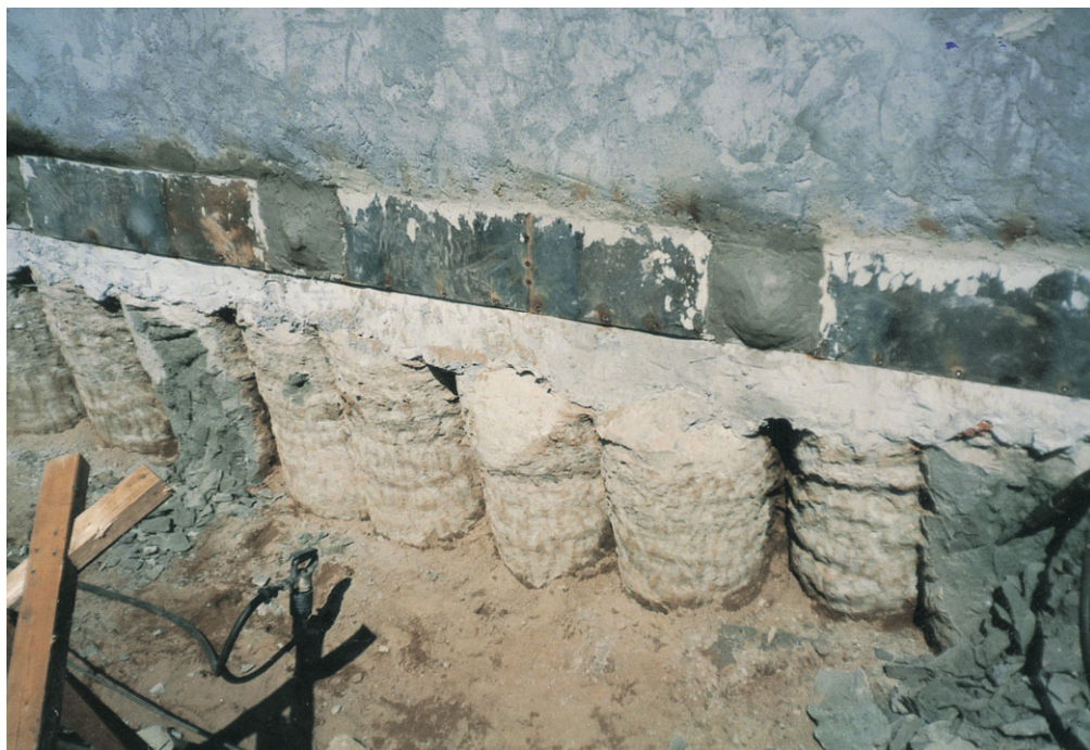
Obnažené pilíře tryskové injektáže zajišťující stavební jámu a podchycující přilehlý objekt (Pod Kotlaskou, Praha)
