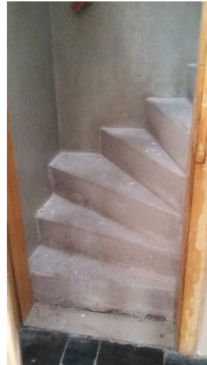
Obr. 18: Kamenné schodiště do sakristie v 2. NP
