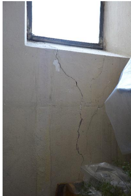
Obr. 52: Svislá trhлина
