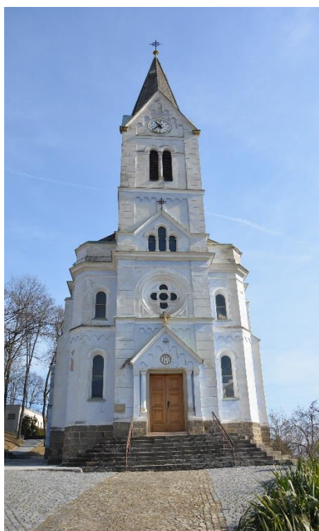
Obr. 7: Pohled z JZ strany na hlavní vstup
