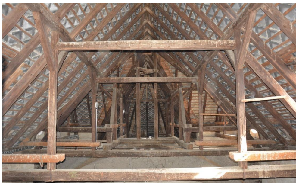
Obr. 19: Pohled do krovu
