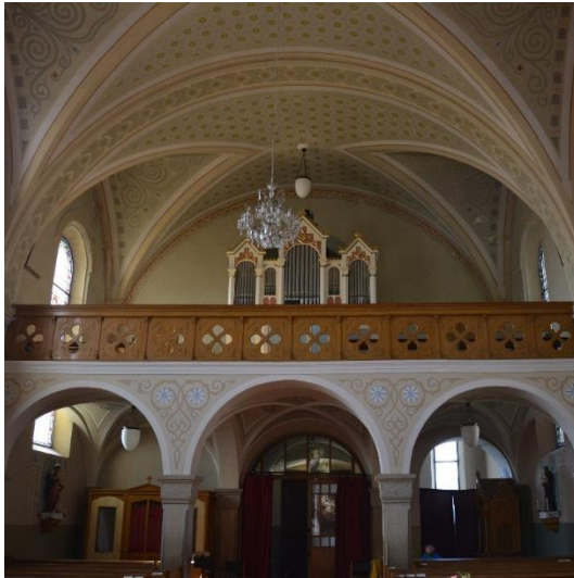
Obr. 14: Pohled na kůr a valenou klenbu s lunetami
