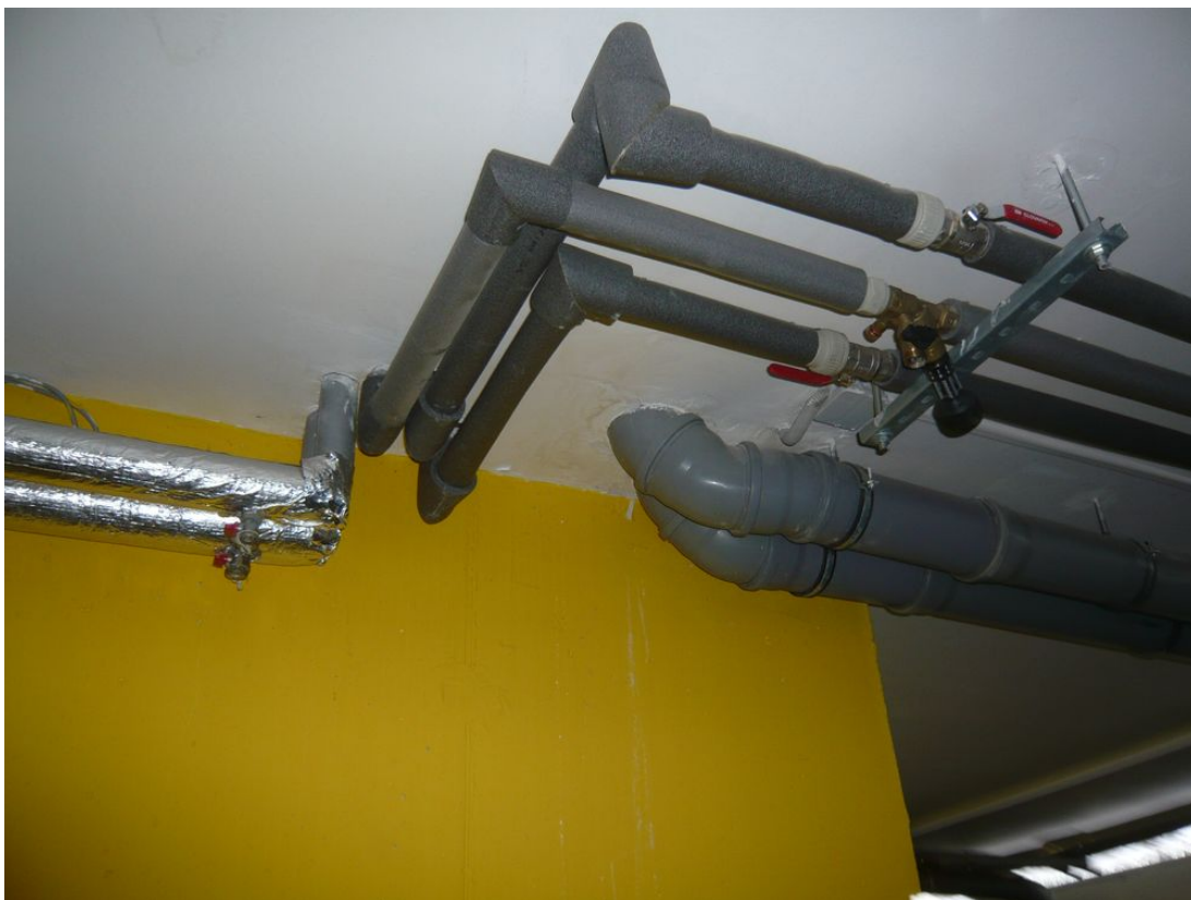
Obr. 5: Izolace potrubí lehčným PP (4)
