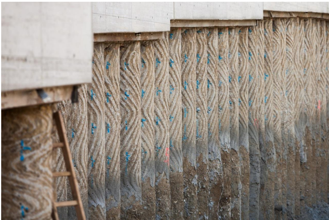
Obr. č. 2: Pilotová stěna [4]
