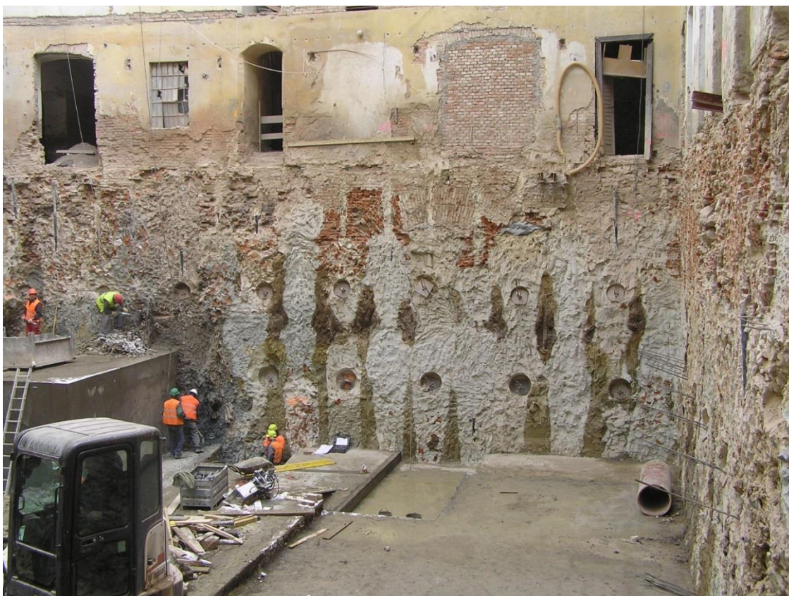
Obr. č. 3: Trysková injektáž [6]
