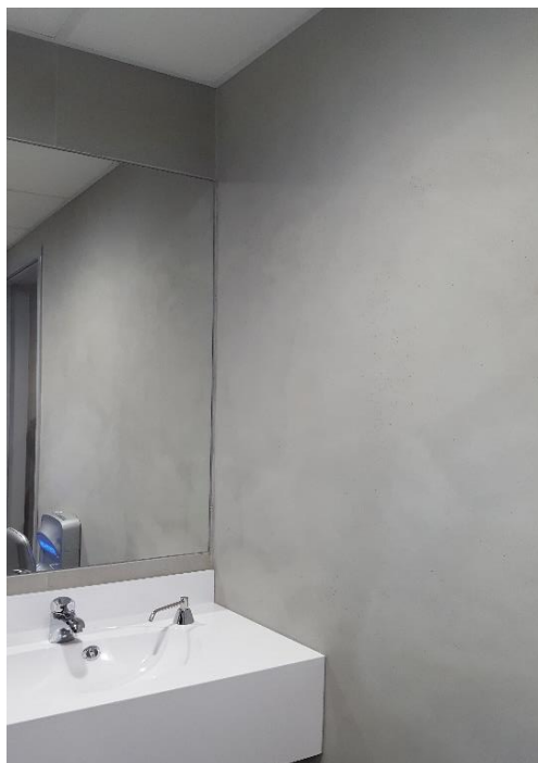
Obr. 16: Stěrka na objektu ČIIRK (vlastní zdroj)
