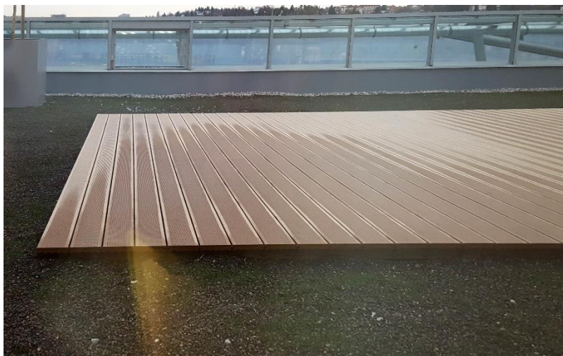
Obr. 12: Terasa na objektu ČIIRK (vlastní zdroj)
