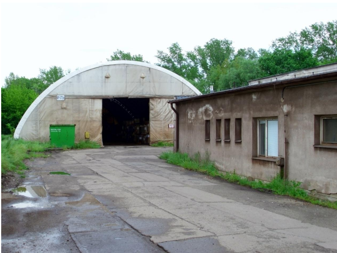
Obrázek 10: Hala K-18 a provozní budova
