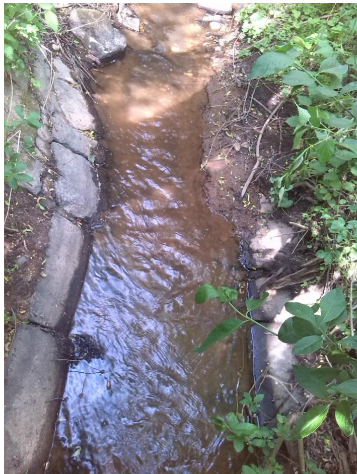
Fotografie č. 6 - Pohled po vodě, na opevnění v profilu pod propustkem.
