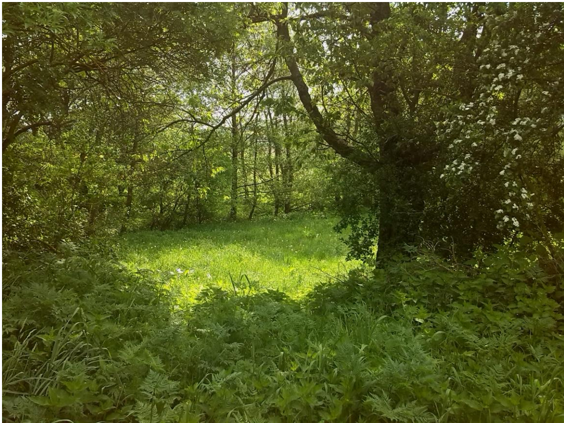
Fotografie č. 8 - Pohled z cesty na budoucí vzdušní líc hráze. Cesta je oproti okolnímu terénu vyvýšená, to je považováno za pozůstatek tělesa hráze.
