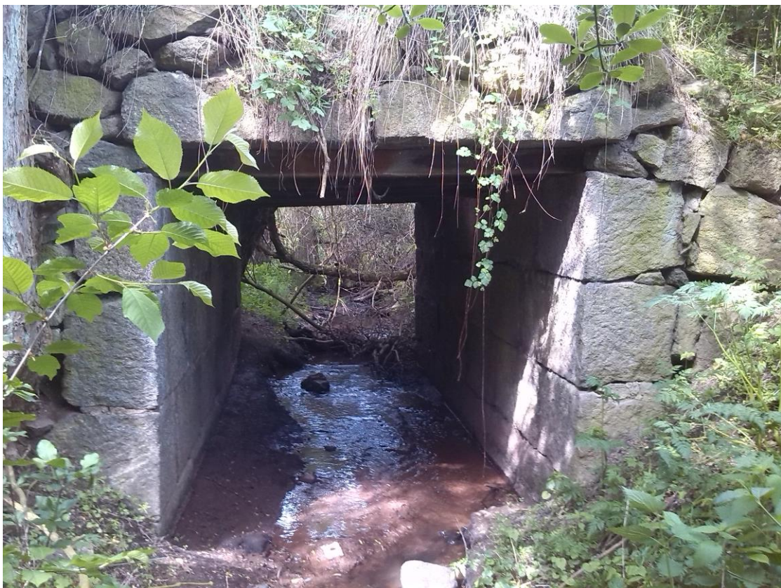
Fotografie č. 4 - Propustek v křížení přístupové cesty s Podvineckým potokem.
