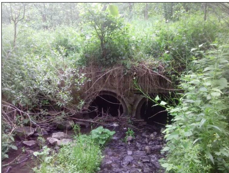
Obrázek 7 – Propustek pod tankovou cestou (foto: Vodoplan, s.r.o.)
