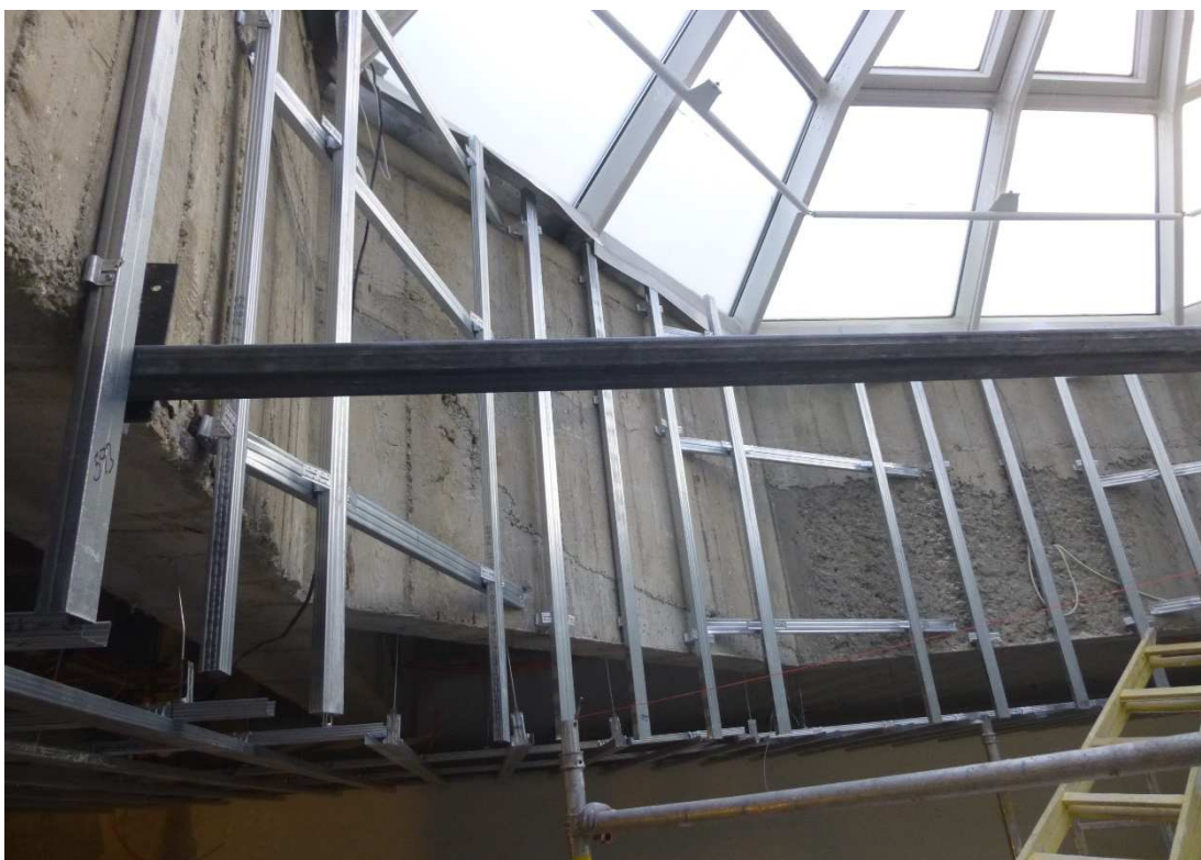
Fotografie č. 14 – Montáž roštu pro předstěnu ostění světlíku
