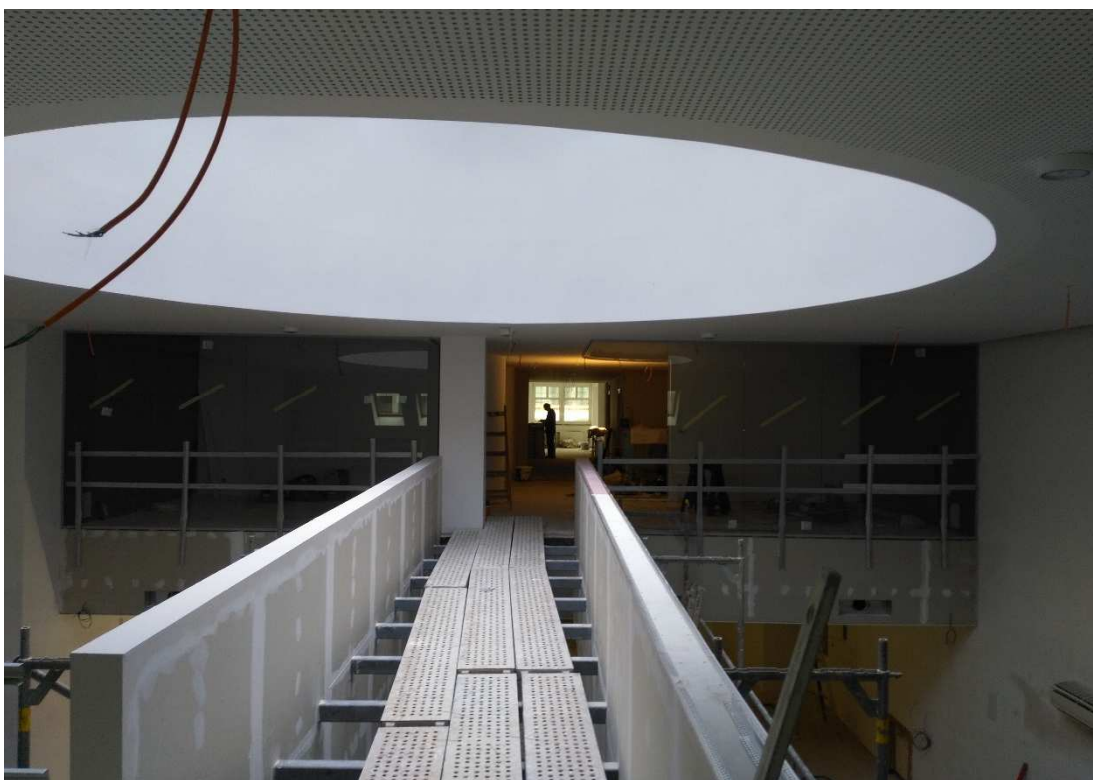
Fotografie č. 19 – Nový akustický podhled a oblouková předstěna světlíku, montáž prosklených stěn
