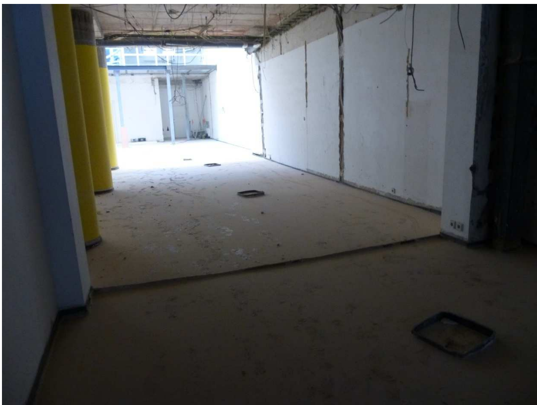
Fotografie č. 9 – Pohled na obchodní halu po realizaci anhydritu
