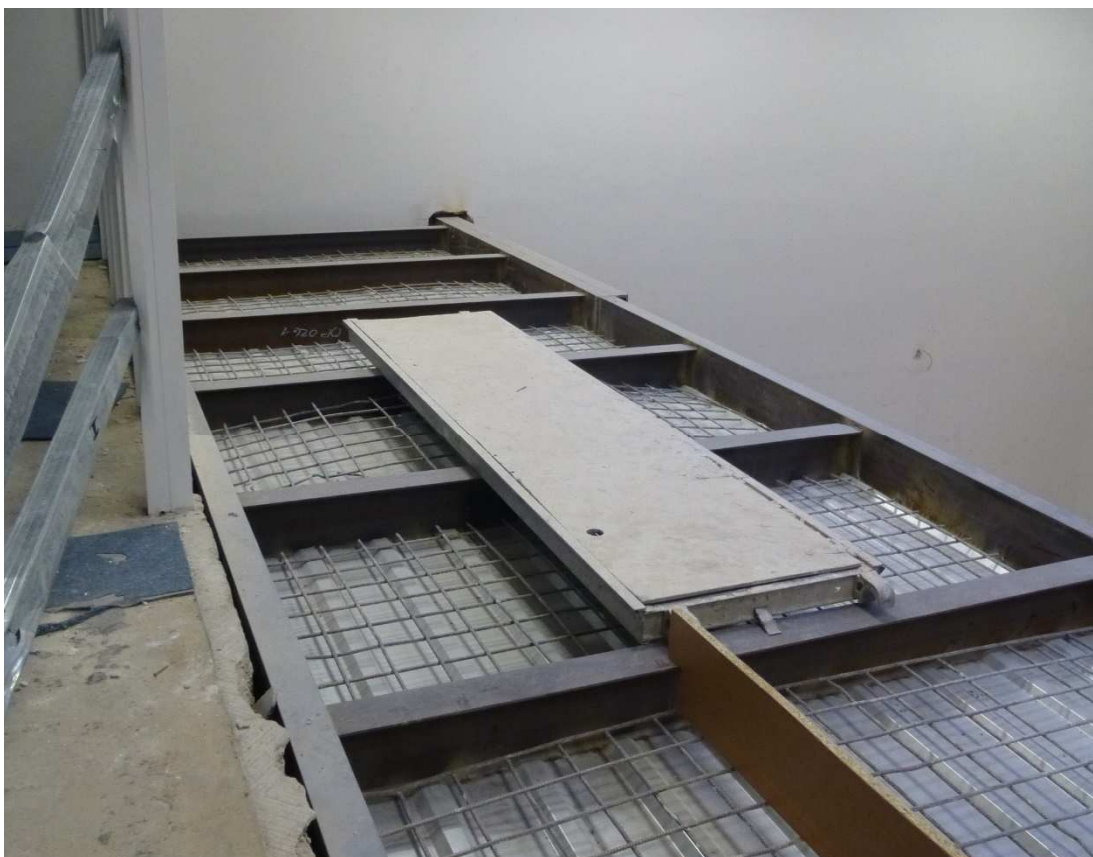
Fotografie č. 11 – Příprava na betonáž stropní desky nad diskretním boxem
