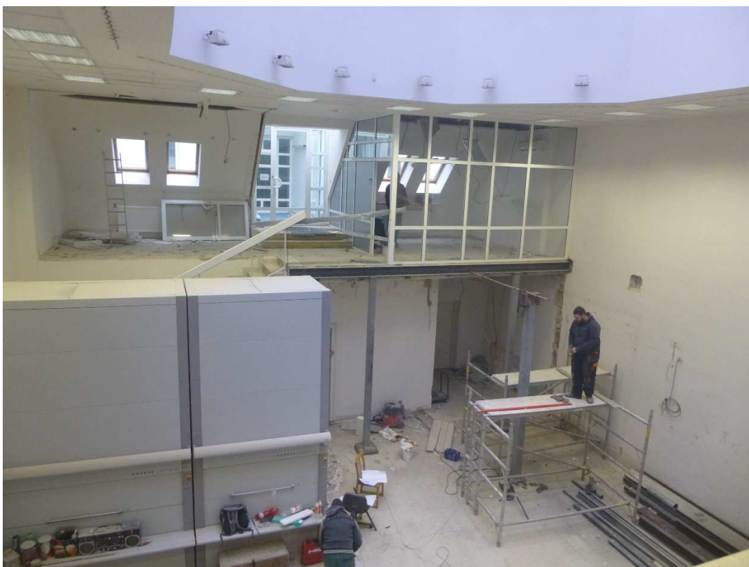
Fotografie č. 6 – Pohled na chodbu ve 4. NP – připravený podhledový rošt
