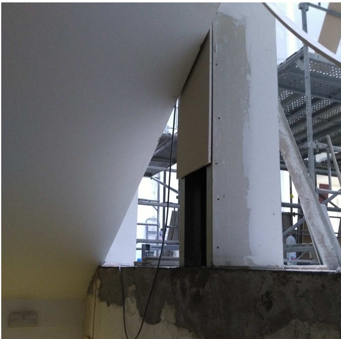
Obrázek č.10: Protipožární obklad nosného ocelového sloupu z desek Habito (Převzato z osobního archivu)
