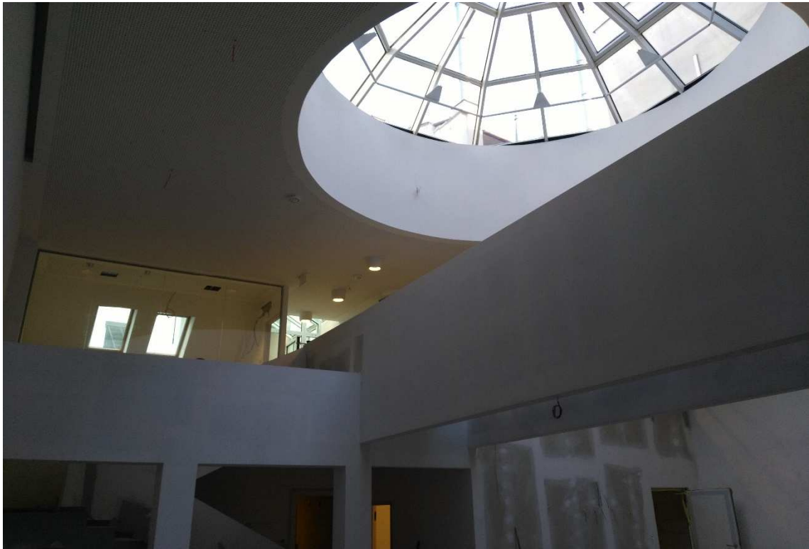
Obrázek č.8: Finální tmelení a konečné úpravy sádrokartonových konstrukcí (Převzato z osobního archivu)
