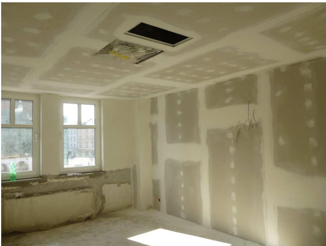
Obrázek č.26: Sádrokartonová příčka po druhém tmelení v kvalitě Q2-Q3 (Převzato z osobního archivu)
