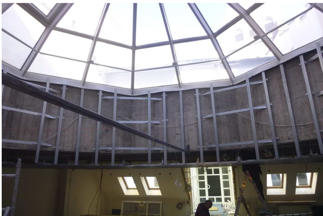
Obrázek č.7: Montáž roštu pro obloukovou předstěnu u ostění světlíku (Převzato z osobního archivu)
