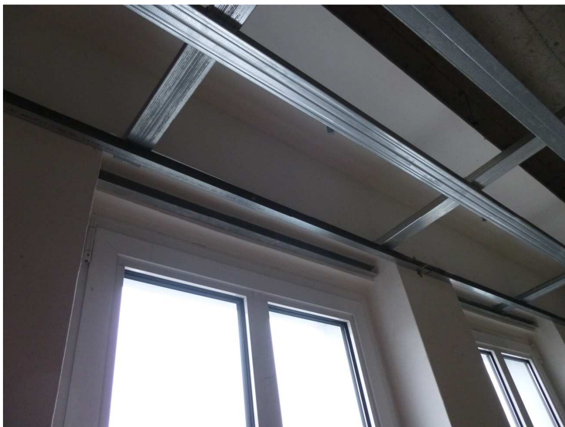
Obrázek č.11: Detail nosného roštu v nadpraží okenního otvoru (Převzato z osobního archivu)
