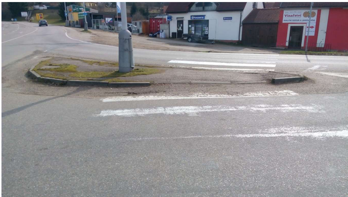
Obrázek 5 – křižovatka silnic II/112 a II/125, pohled na zvýšený ostrůvek a ulici Riegrova
