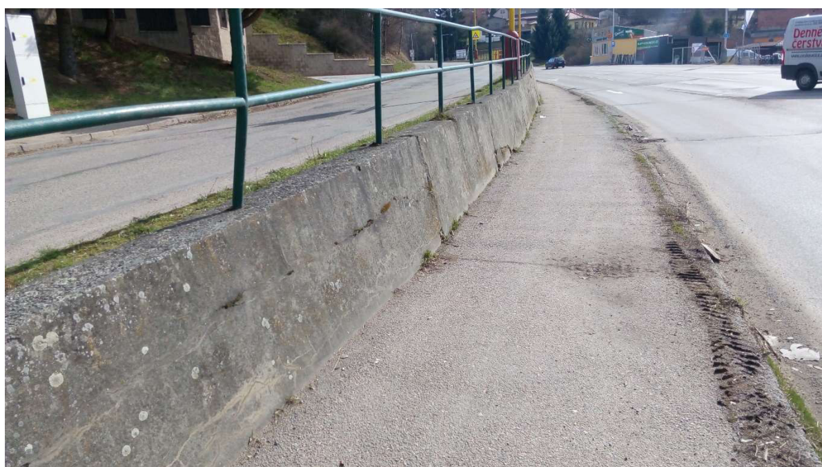
Obrázek 2 – ulice Vlasákova, pohled na chodník podél opěrné stěny směrem k ulici Riegrova
