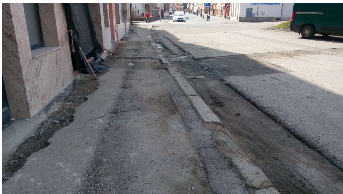
Obrázek 11 – stávající stav ulice „U Kozla“
