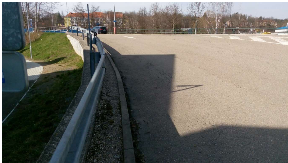
Obrázek 13 – stávající stav ulice „U Kozla“, detail opěrné zdi
