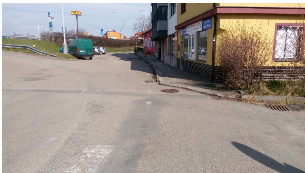
Obrázek 10 – stávající stav ulice „U Kozla“
