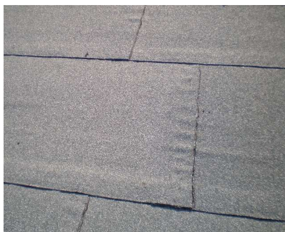
Obr. 20: Přetavení asfaltového pásu Zdroj: osobní archiv Káně L.
