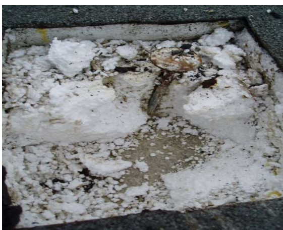
Obr. 19: Chybně užito fasádních hmoždinek Zdroj: osobní archiv Káně L.
