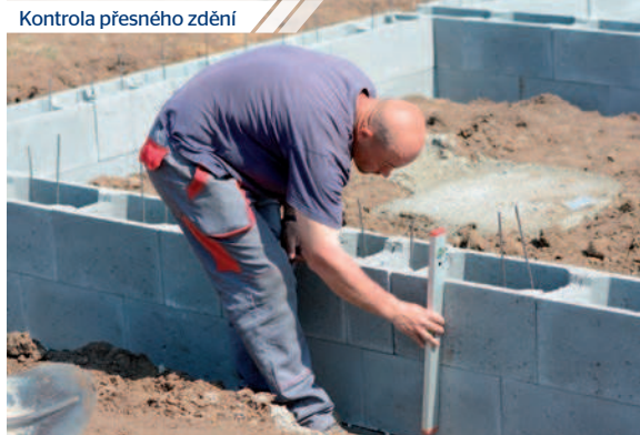
Kontrola přesného zdění
