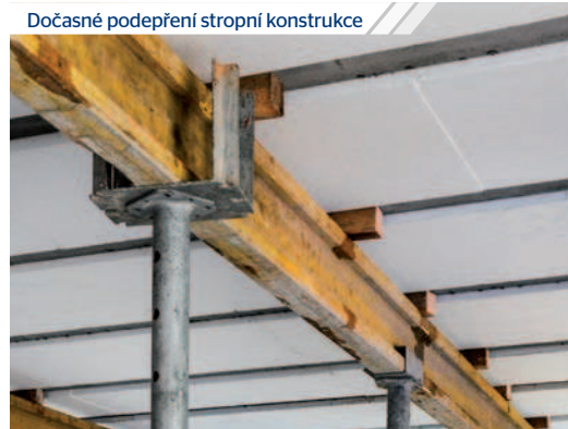
Dočasné podepření stropní konstrukce
