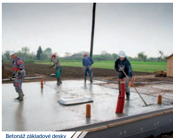
Betonáž základové desky
