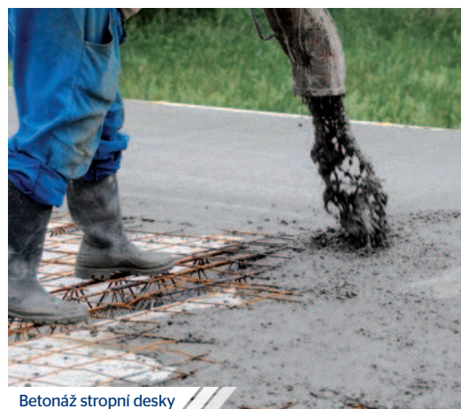
Betonáž stropní desky
