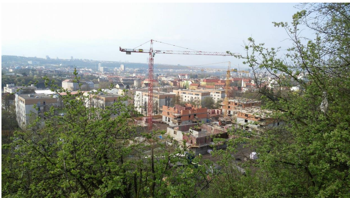
Obrázek 39: Výstavba bytových domů (Foto: R. Kubínová, 5. 4. 2017)
