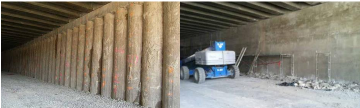
Obr. 8, 9: Vlevo převrtávaná pilotová stěna, vpravo stěna po aplikaci stříkaného betonu (zdroj: [8])
