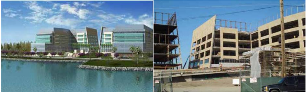
Obr. 2,3: Vlevo vizualizace kancelářského komplexu, vpravo fotografie z výstavby (zdroj: [5])
