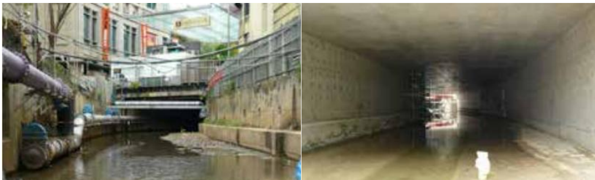
Obr. 1, 2: Vlevo původní kanál, vpravo vybetonovaná konstrukce vedoucí podzemím obchodního centra (zdroj: [4])
