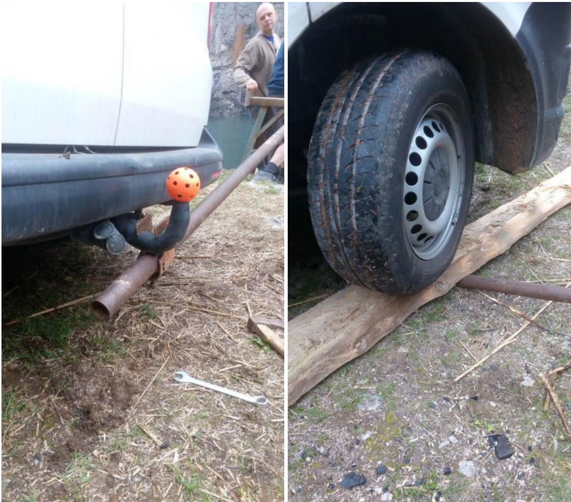
Obr. 31, 32: Vlevo připevnění lešenářské trubky k dodávce pomocí lešenářské spojky, vpravo jednodušší ale stejně funkční zatížení vlastní tíhou dodávky přes prkno
