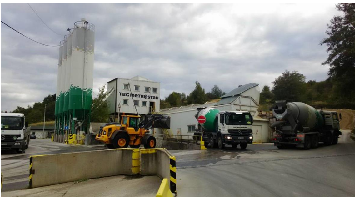
Obr. 3.04- Betonárna TBG Metrostav v Radlicích
