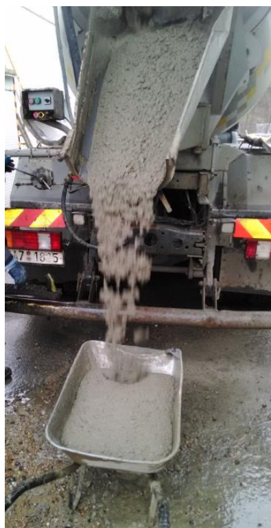
Obr. 3.01- odebrání betonu z mixu
