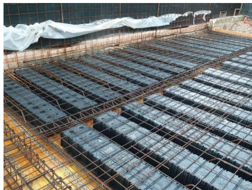
Obr. 2.10 U-Bahn Beton – rozmístění tvarovek zdroj [15]
