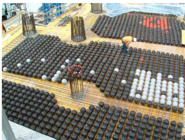
Obr. 2.8 Systém Cobix – rozmístění tvarovek zdroj [13]
