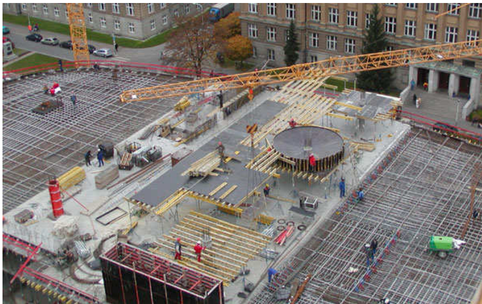
Obr. 2.21 Dodatečně předpjatá monolitická stropní konstrukce (zdroj: [7])
