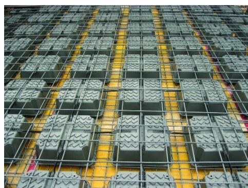
Obr. 2.5 U-Boot Beton – rozmístění tvarovek zdroj [10]
