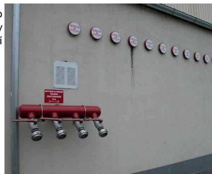
Obrázek č. 2 – Armatura pro připojení mobilní techniky JPO na PHZ; v pozadí poplachové zvony [13]
