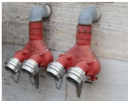
Obrázek č. 2 – Armatura pro připojení mobilní techniky JPO na PHZ; v pozadí poplachové zvony [13]
