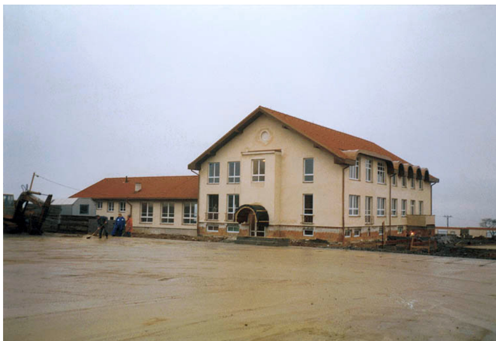
Obrázek 12; Stavba travnatého hřiště - Švihov u Klatov
