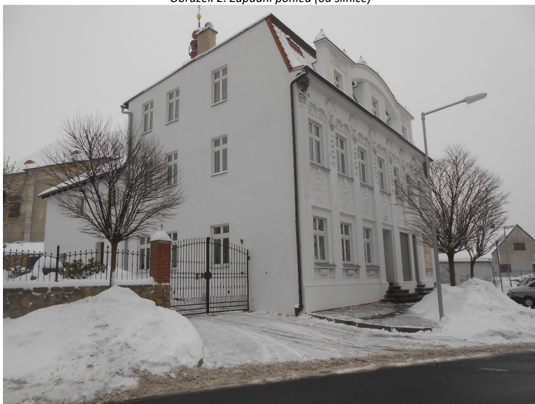
Obrázek 2: Západní pohled (od silnice)
