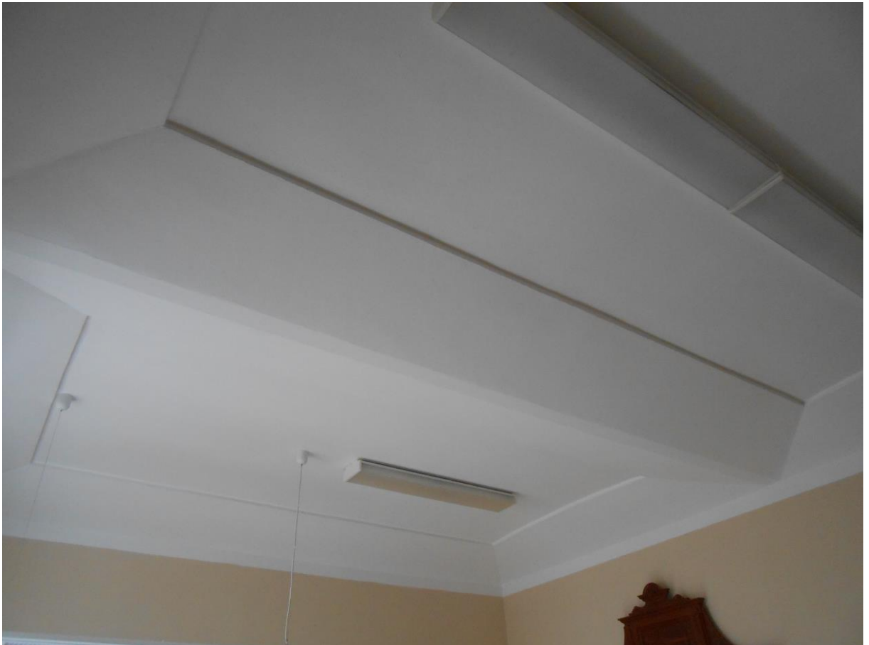
Obrázek 25: Reálná fotografie zrcadlové klenby v místnosti 1.2
