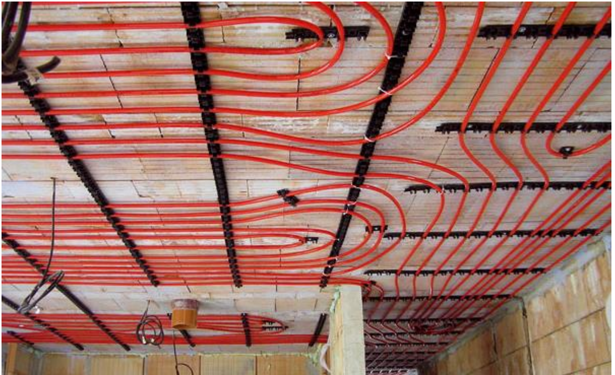
Obrázek 15: Trubkové stropní vytápění [28]
