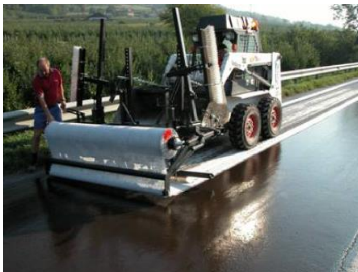
Obr. č. 4 Pokládka geokompozitu při obnově svrchních vrstev komunikace [8]
