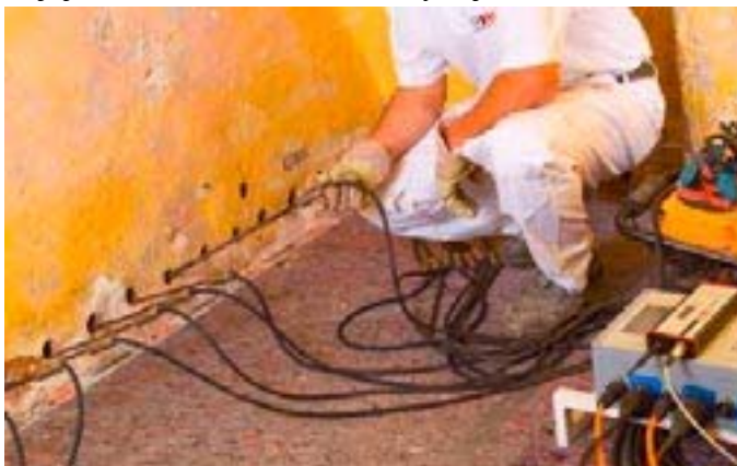
Obr. 25 Vyhřívání vrtů ve zdivu
