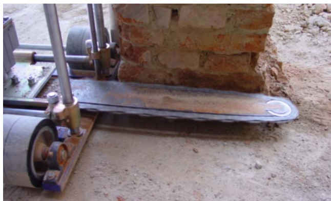
Obr. 28 Strojní podřezávání zdiva řetězovou pilou
