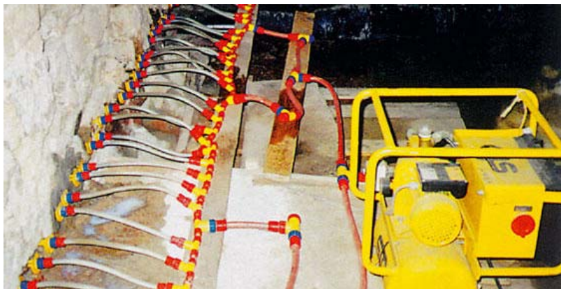
Ohr. 24 Příklad tlakové iniektáže
