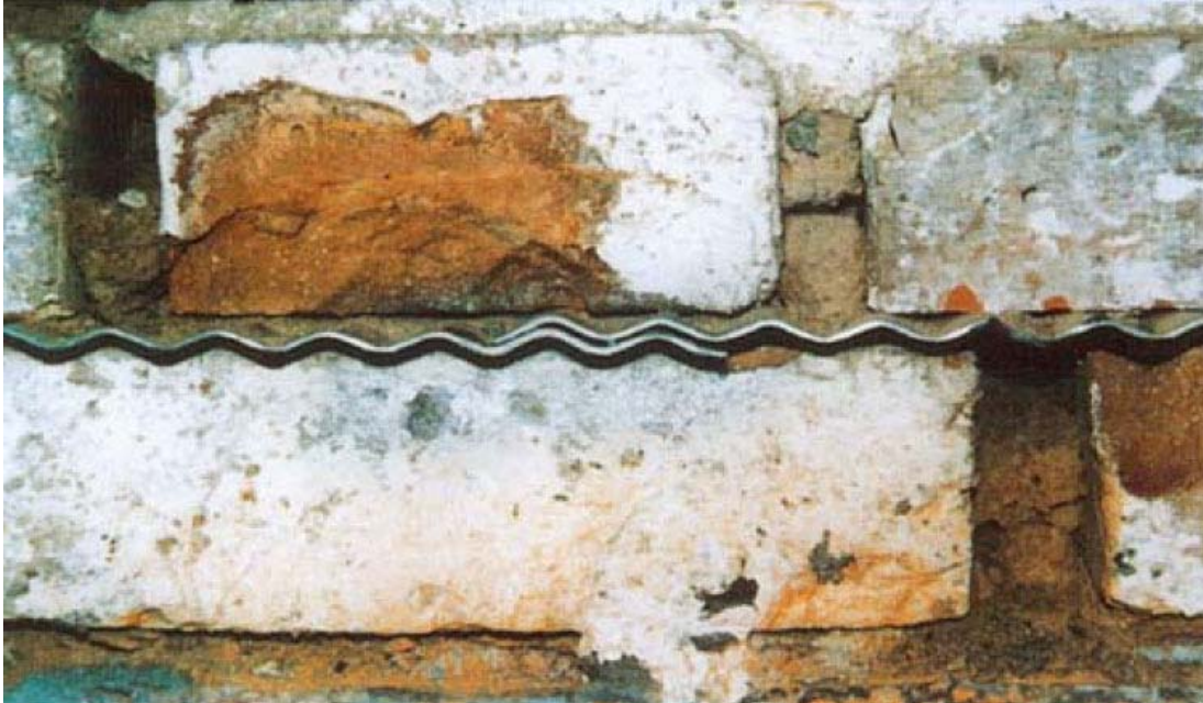
Obr. 31 Spoj plechů přesahem
