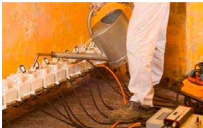
Obr. 26 Plnění vrtů parafínem
