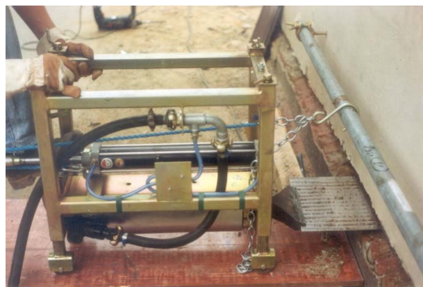
Obr. 30 Zarážení nerezových desek do zdiva
