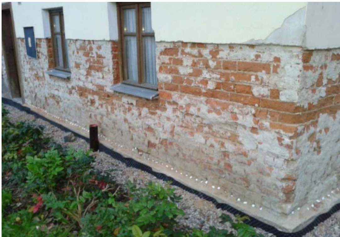
Obr. 17 Příklad provedení injektáže objektu
