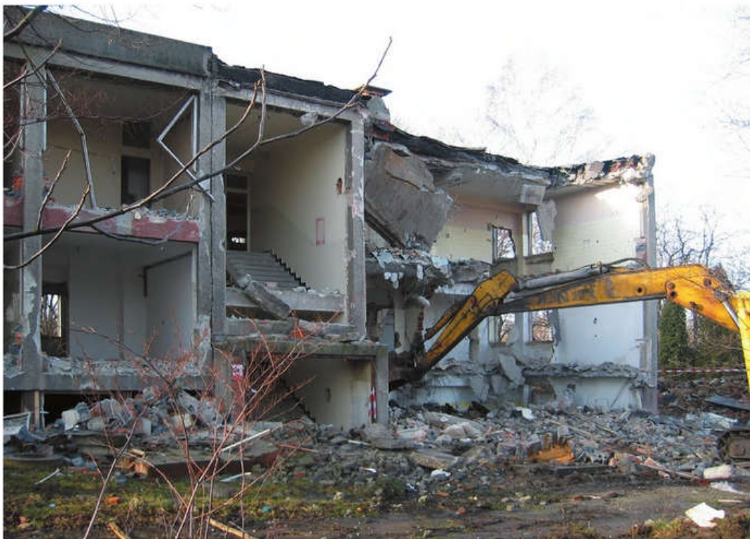
Obr. č. 5: Ukázka demolice celého objektu s použitím těžké mechanizace
