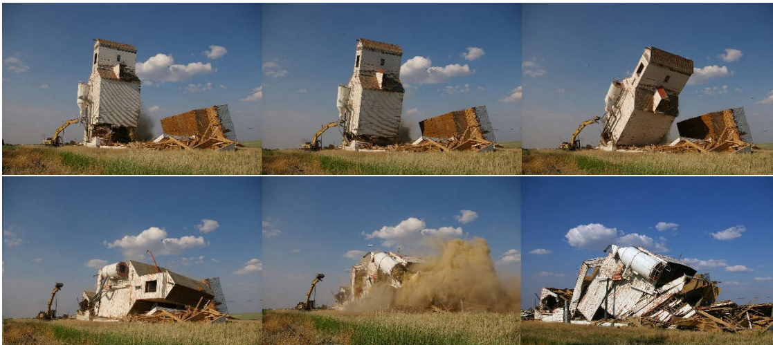
Obr. č. 4: Demolice posledního výškového skladu obilí v Mendham, Saskatchewan.
