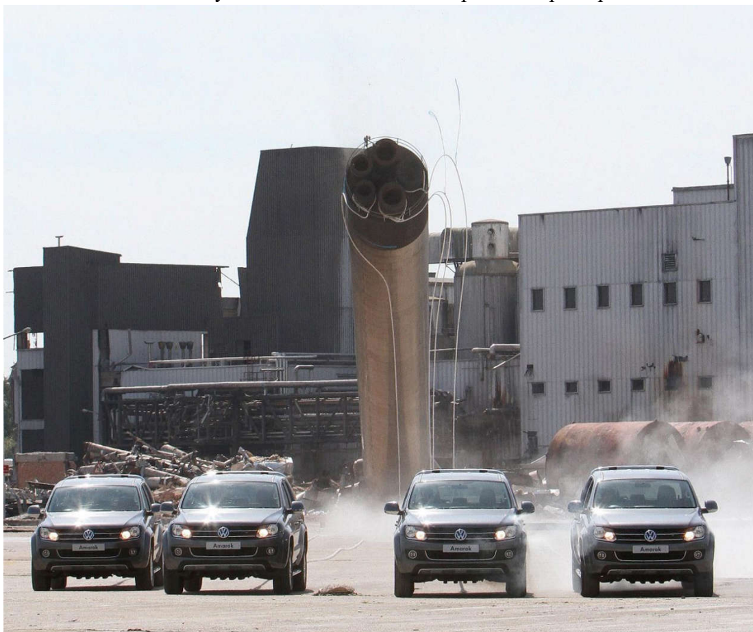
Obr. č. 2: Stržení 67m vysokého ocelového komínu pomocí 4 pickupů.
